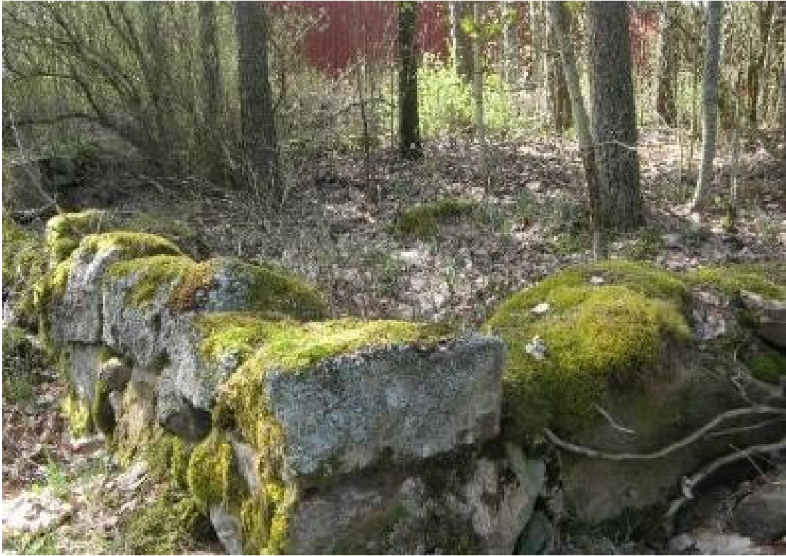
SKDG201910:20 Hyyperän viimeisen päärakennuksen kivijalkaa.
