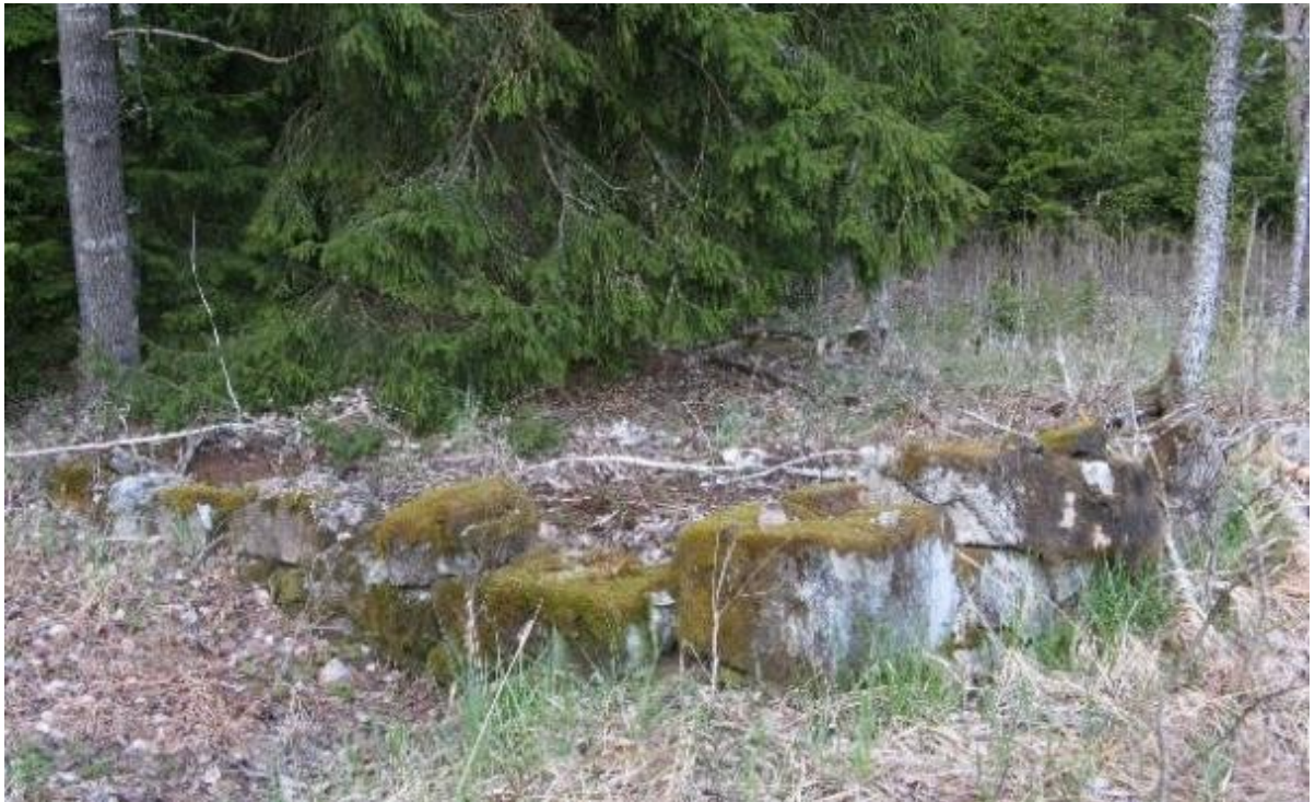
SKDG201901:105 Kivijalka torpan asuinrakennuksen luoteispuolella.
