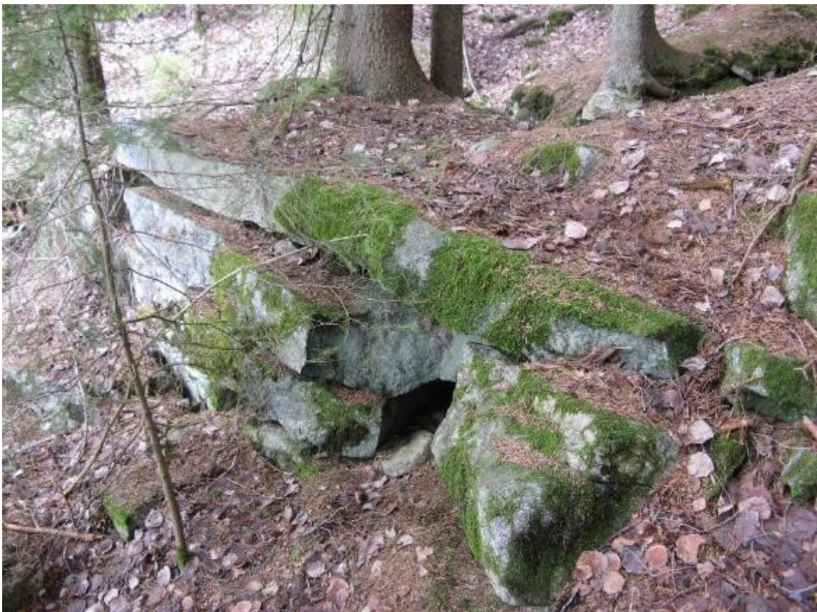
SKDG201901:73 Kankare 3, alempi kiviperusta ja kuvassa keskellä näkyvä pieni aukko.
