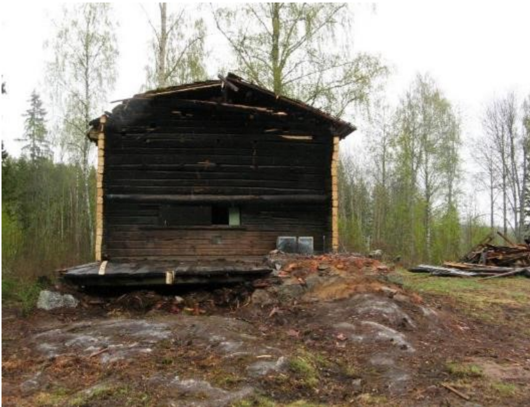
SKDG201901:29 Pihapiirin koillispuolella puretaan vanhaa rakennusta. Oikeassa nurkassa näkyy tulisijan- ja piipunperusta, joka on tehty kallion päälle.
