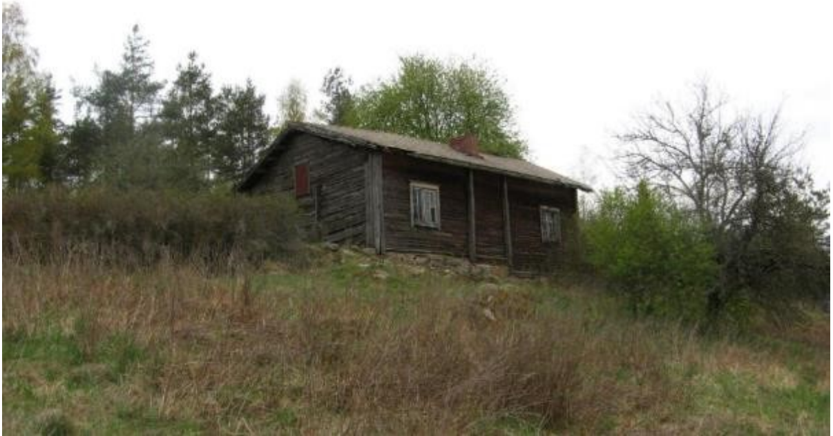
SKDG201901:38 Ylimmäisen tontilla säilynyt vanha rakennus kaakosta.
