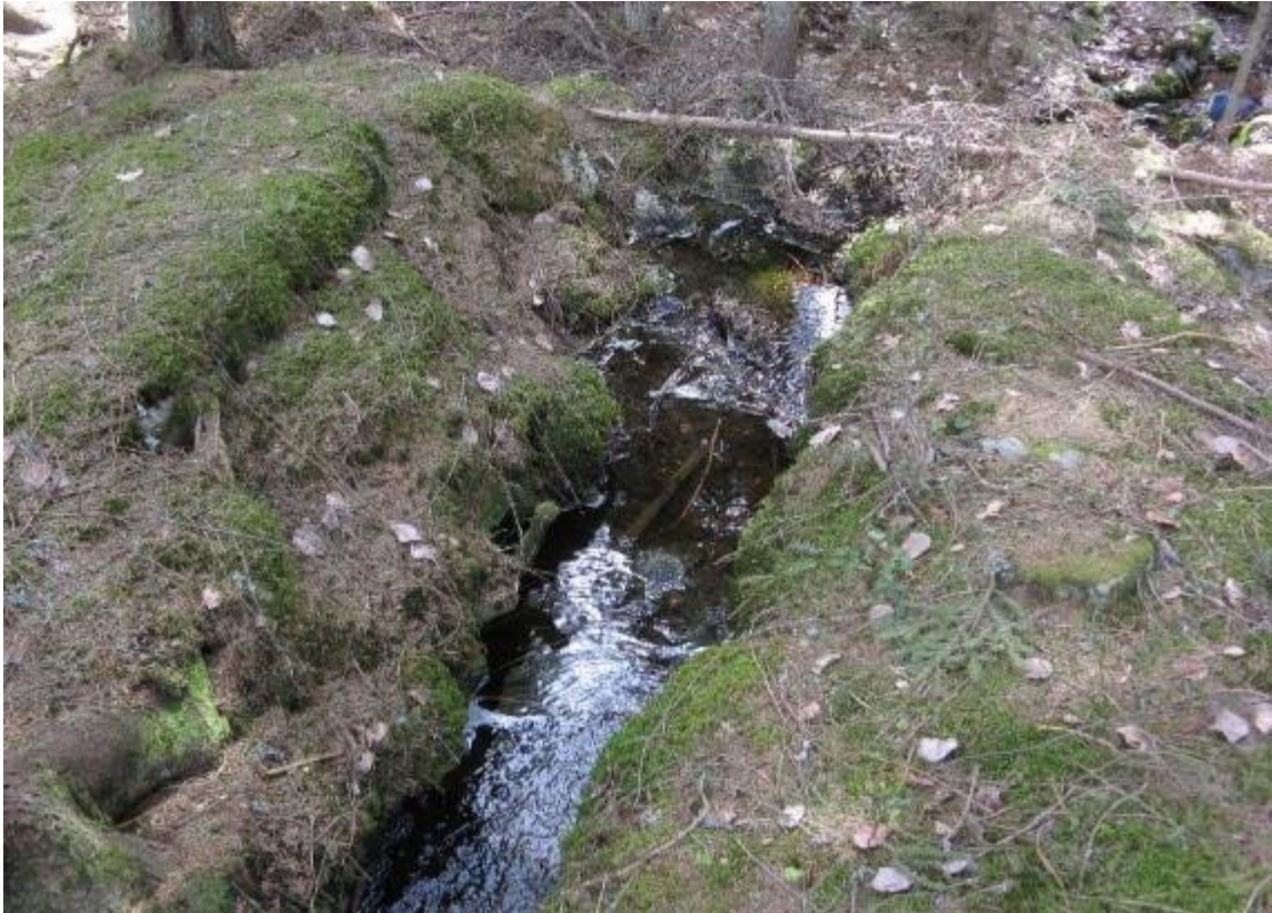
SKDG201901:69 Kankare 3 ylempi kivirakenne ylhäältä.
