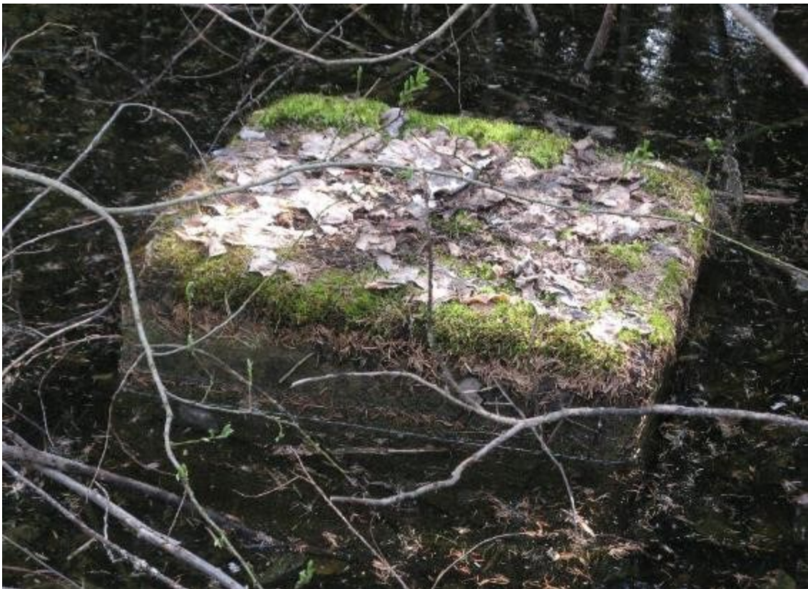
SKDG209101: 68 Valettu pylväs tien toisella puolella, vesilammikossa, tien vieressä. Tukipylväitä on käytetty sekä kourujen tukemiseen, että itse myllyrakennuksen perustana.
