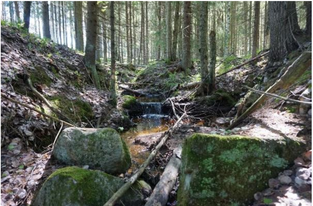
SKDG201901:97 Padon keskeltä kulkeva purouoma jäljellä olevine rakenteineen. Taustalla näkyvä pieni putous kulkee säilyneen, poikittaisen tukihirren päältä.
