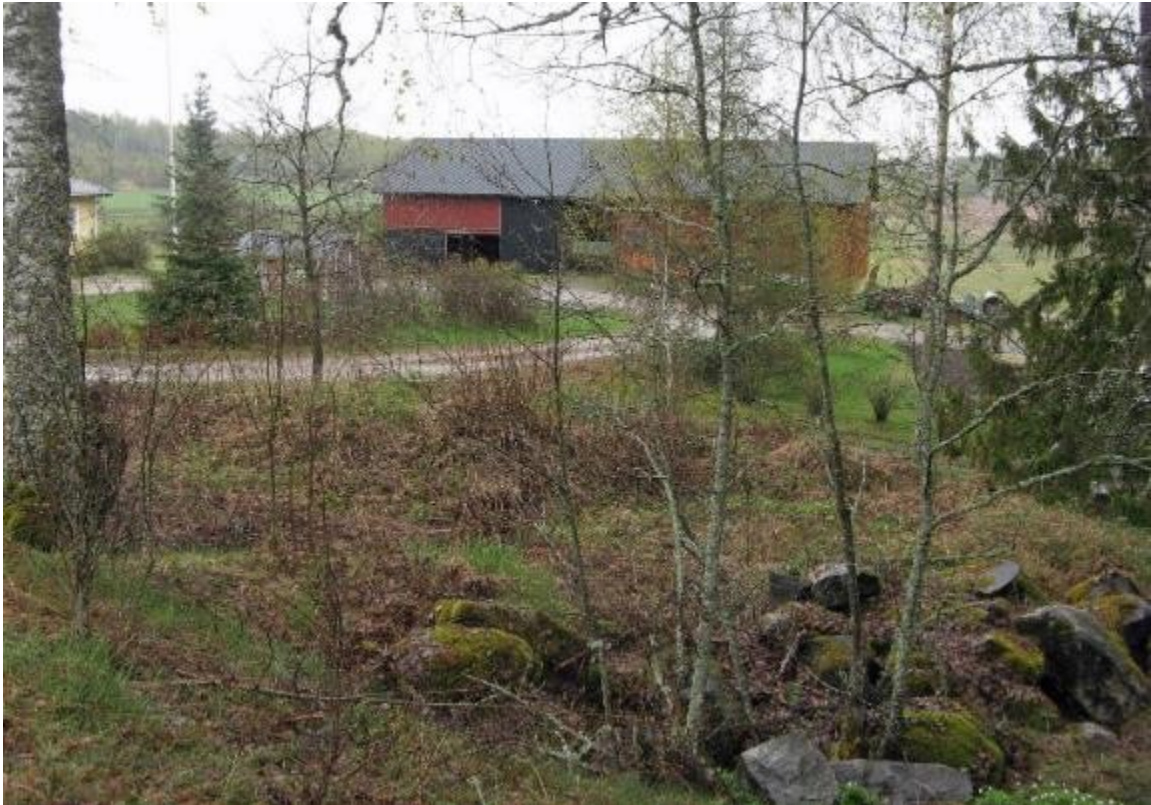
SKDG201901:25 Kuumalan tonttia, etualalla puretun rakennuksen perustusta.
