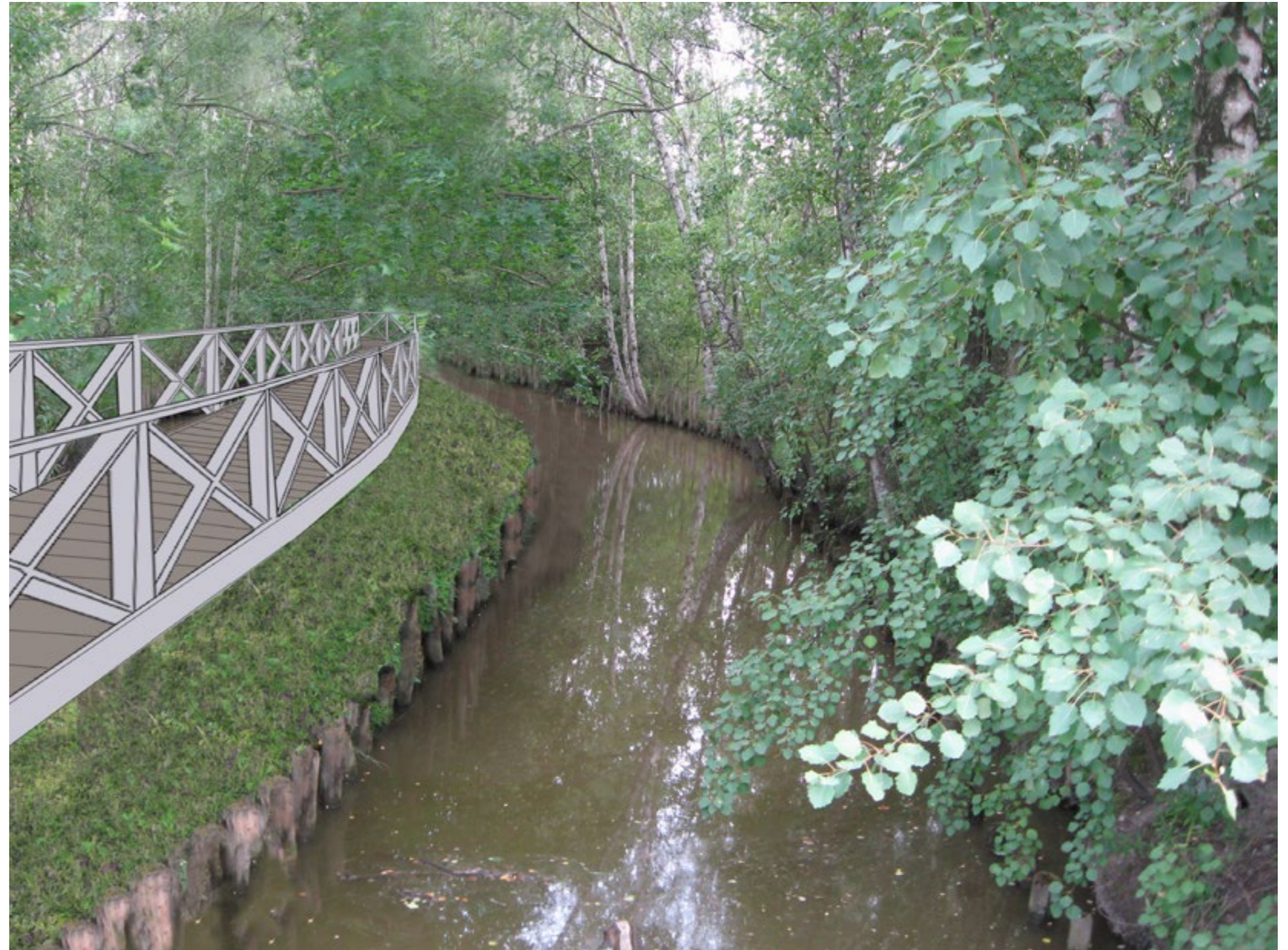
Näkymä 2. Näkymä Tehdaskadun sillalta Sofianpuiston suuntaan. Uuden puukäytävän ristikkokuvion idea on ammennettu Vähäsillan nykyisestä kaiteesta
