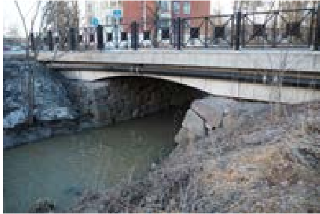
Vähäsillan vanhat kiviarkut on säilytetty uuden sillan alla
