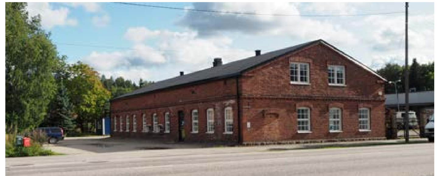
Entinen nahkatehtaan rakennus Sofianpuiston vierellä
