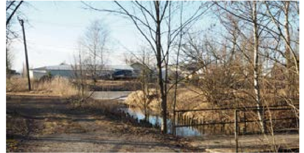
K3. Vähäjoki liittyy Salonjokeen. Kaivettu uoman osa on tuettu puupaaluin
