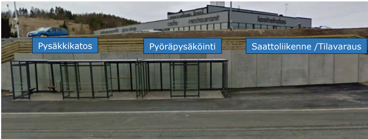
Kuva 36. Pyöräpysäköintiä voidaan tarvittaessa laajentaa hieman nykyisen tilan kapasiteetin täytyessä. (Maastokäynti 7/2016)
