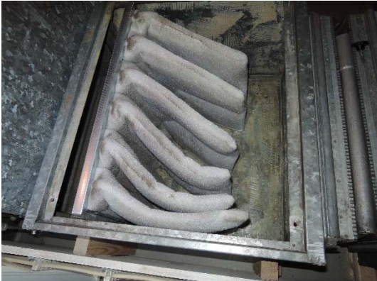
Kuva 42. Suodatinkammion kuitulähteet on poistettu.
