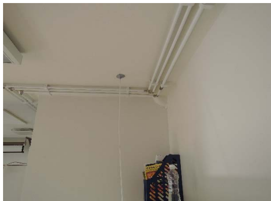
Kuva 36. Merkkiainetta laskettiin rakennuksen B yläpohjaan huoneesta 59.
