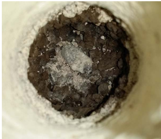
Kuva 28. Laboratorion 46 välipohjassa (lattiassa) oli betonilaatan alla eristeenä korkkia (M30, PAH2).
