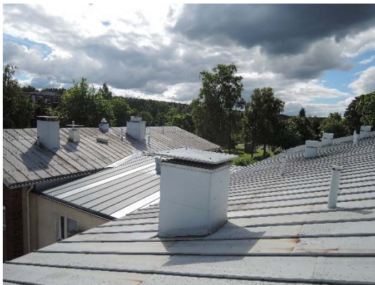
Kuva 32. Rakennusten vesikatteena on pelti.
