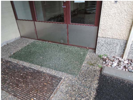
Kuva 22. Rakennuksen A eteläpäädyn ulko-oven kohdalla on selvästi havaittavissa rakennuksen valesokkelirakenne.
