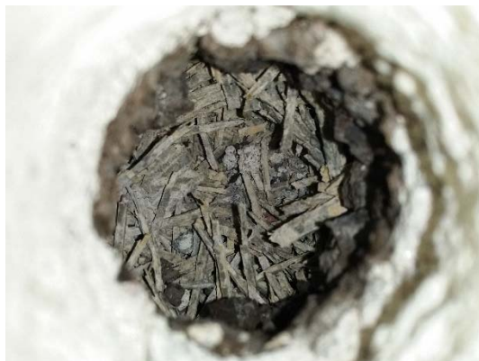
Kuva 14. Hammashoitolan alapohjan kaksoislaattarakenteen eristeenä oleva lastuvilla on mikrobivaurioitunut.
