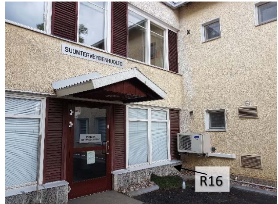
Kuva 23. Alakerroksessa seinien rakenneavaukset tehtiin valesokkelikorkeudelle.
