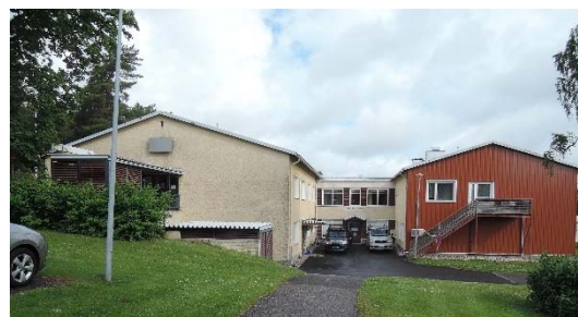
Kuva 5. Hammashoitolan eteläpäädyn seinä on uusittu keväällä 2017.
