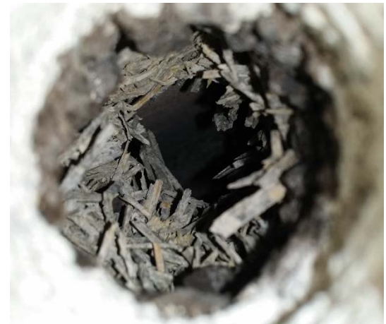
Kuva 29. Korkin alla oli lastuvillalevy (Toja, M31), ilmatila ja puru-/villatäyttö (M32).
