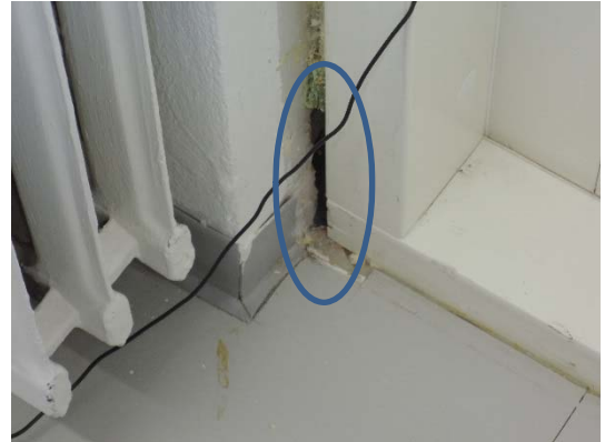
Kuva 25. Merkittävä ilmavuo to tarkkaamon 60 parvekkeen oven vieressä.
