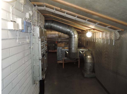
Kuva 40. Ilmanvaihtokoneet sijaitsevat konehuoneissa rakennusten ullakolla (rakennus B).
