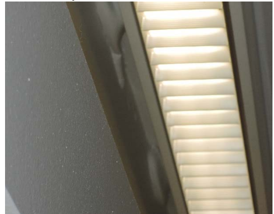
Kuva 9. Vesitaskuja huoneen 185 katossa pilarin ja valaisimen välissä.
