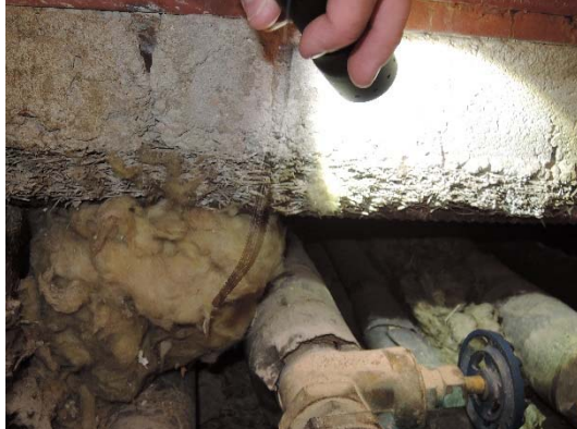
Kuvat 18. Kanaalissa on runsaasti herkästi vaurioituvia materiaaleja.
