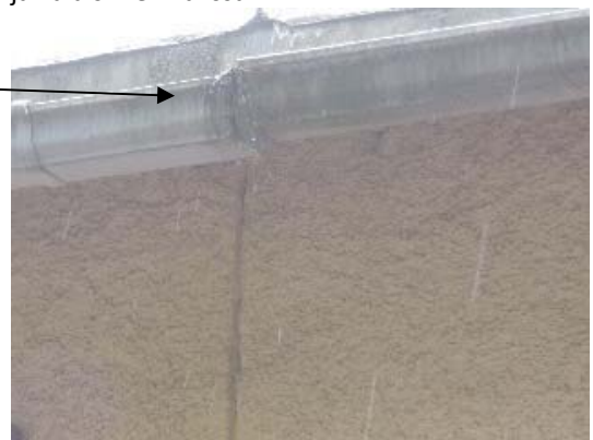
Kuvat 10 ja 11. Huoneen 185 kohdalla ulkoseinä kastuu vuotavan ränniliitoksen takia. Maanpinta viettää rakennusta kohti koko seinustalla.
