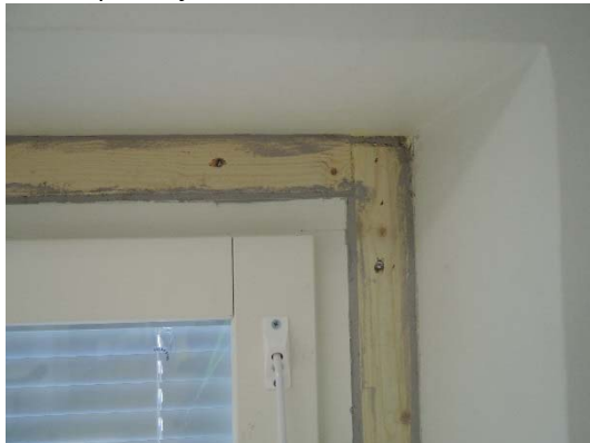
Kuva 26. Työterveyshuollon tiloissa tehtiin ikku- noiden tiivistyskorjauksia tutkimusten aikana
