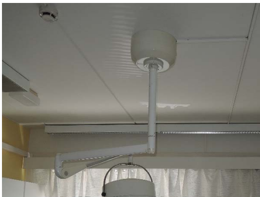
Kuva 34. Rakennuksen A yläpohjan ontelolaatta on tiivis eikä vaurioidu kosteudesta.
