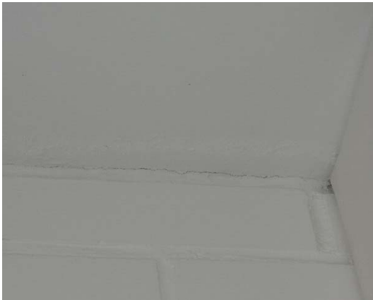
Kuva 8. Maali kupruilee huoneen 194 katossa.
