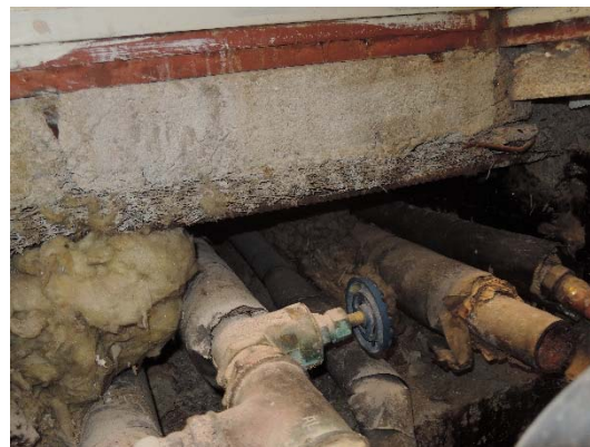
Kuva 15. Hammashoitolan putkikanaalin epätiivien luukkujen kautta epäpuhtauksia voi kulkeutua sisälle.
