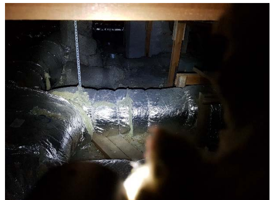
Kuva 35. Rakennuksen B matalan ullakkotilan kautta ei kyetty luotettavasti kartoittamaan mahdollisia vesivuotoja.
