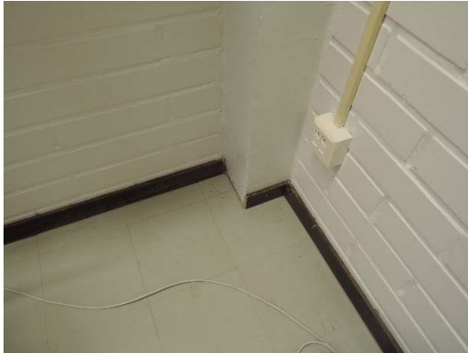
Kuva 24. Valesokkelin eristetilasta havaittiin ilma- vuotoa pilarin juuresta huoneessa 036.
