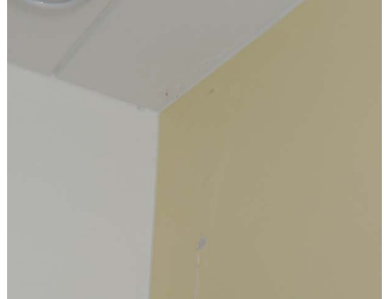
Kuva 7. Vesivuodon aiheuttamia jälkiä huoneen 193 katossa ja seinässä.
