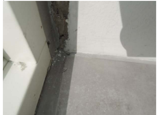
Kuva 27. Tiivistyskorjauksin merkittäviä ilmavuo- toja kyettiin rajoittamaan pistemäisiksi.
