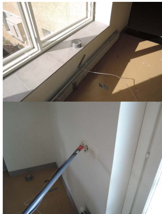
Kuva 39. Merkkiainetta laskettiin rakenneavauksien kautta seinän eristetilaan (yllä) ja sen kulkeutumista sisäilmaan havainnoitiin vetyilmaisimella.
