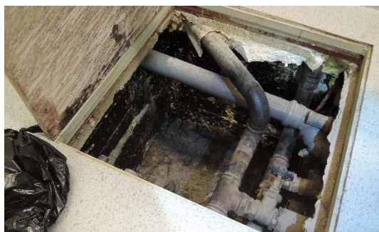
Kuva 16. Hammashoitolan lattian alla kulkee putkikanaali.
