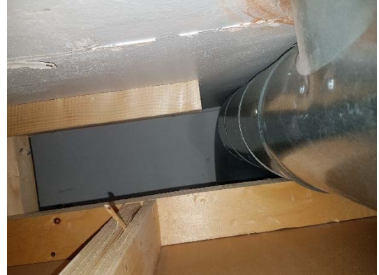
Kuva 19. Pystykuilujen kautta ilmaa voi kulkeutua kerrosten välillä.
