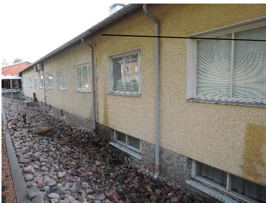
Kuvat 10 ja 11. Huoneen 185 kohdalla ulkoseinä kastuu vuotavan ränniliitoksen takia. Maanpinta viettää rakennusta kohti koko seinustalla.
