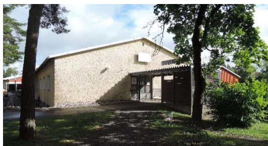
Kuva 4. Lännen puoleisen rakennuksen ylemmässä kerroksessa on terveysaseman vastaanototilat.
