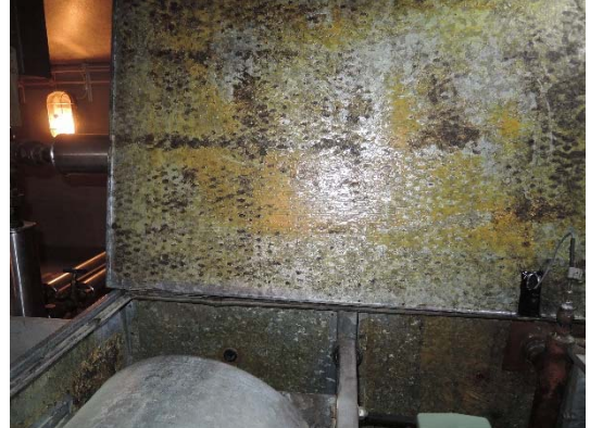
Kuva 41. Ilmanvaihtojärjestelmän kuitulähteet on poistettu kesällä 2010.
