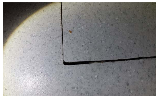
Kuva 17. Kanaalin tarkistusluukut eivät ole ilmatiiviitä.
