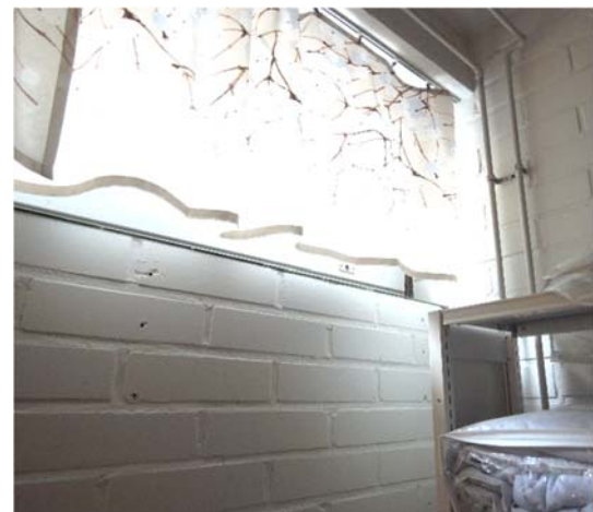
Kuva 21. Maanvastaisissa seinissä on tiilikuoren takana mineraalivillaeristeet.
