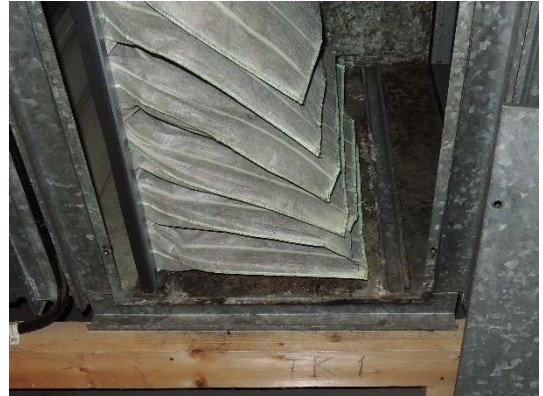
Kuva 43. Tuloilmakoneen TK-1 suodatinkammion pohjalle on päässyt vettä.
