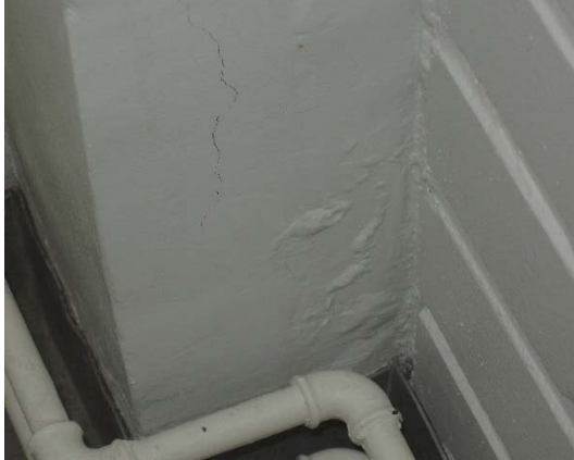
Kuva 6. Kosteusvaurio maanvastaisen seinän pilarissa.
