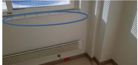
Kuva 42. Ilmavuotoa ikkunaliittymästä.
