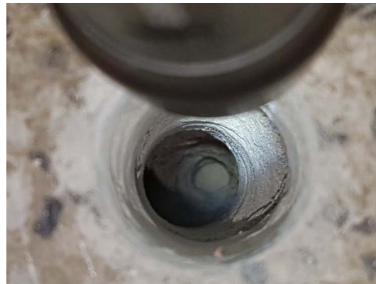
Kuvat 17 ja 18. Porrastasanteen 075 lastuvillaeristeisen laatan alla oli maapohjainen ilmatila, josta avauksen kautta kulkeutui sisälle lämmintä, pahanhajuista ilmaa.
