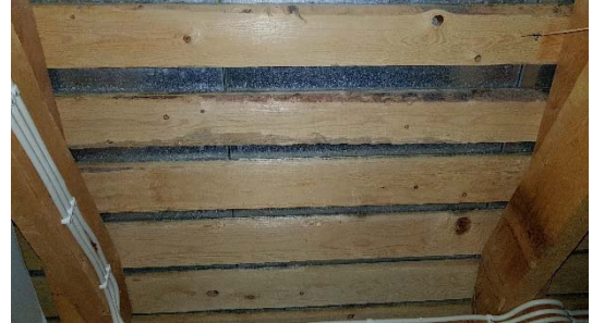
Kuvat 37 ja 38. Laajennusosan yläpohjan puurakenteet ovat hyväkuntoiset.
