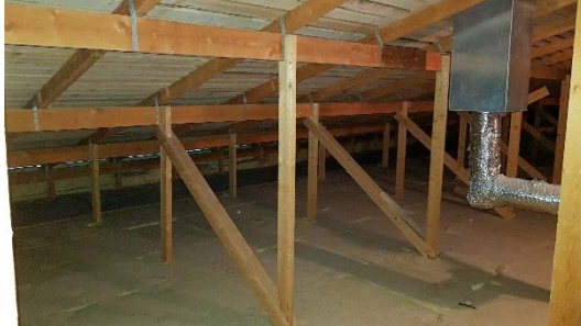
Kuvat 37 ja 38. Laajennusosan yläpohjan puurakenteet ovat hyväkuntoiset.
