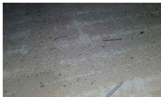
Kuva 34. Palopermannon pintaan on muodostunut kattolaudoituksia noudattava vaalea kuvio.
