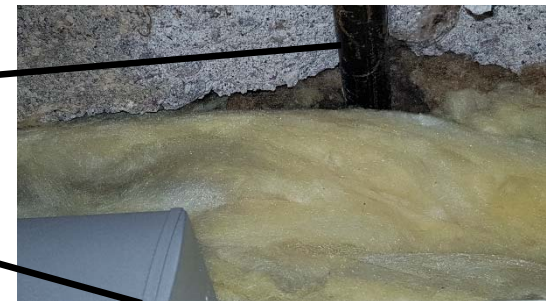
Kuvat 27 ja 28. Happivaraston 023 ulko-oven päältä on suora ilmayhteys seinän eristetilaan.
