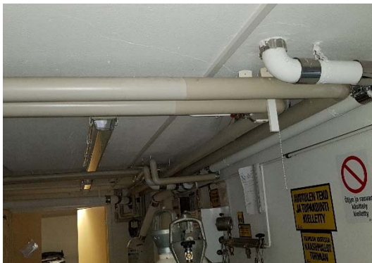
Kuva 29. Happivaraston katon nurkkaan tehdystä avauksesta R21 todettiin välipohjan puru-/hiekkatäytteen mikrobivaurioituneen (näyte M34).
