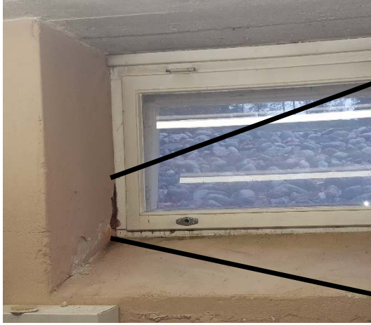
Kuvat 21 ja 22. Maanvastaisten seinien yläosien ikkuna-asennukset eivät ole tiiviit. Ikkunariveestä otetussa materiaalinäytteessä M28 esiintyi aktiivista mikrobikasvua.
