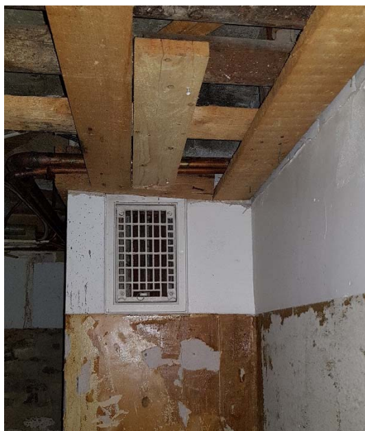
Kuva 45. Huoneen 078 WC-tilan pystyhormin kautta kulkeutuu ilmaa kellarista yläkertaan.
