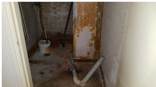
Kuva 4. Huoneen 078 edustan WC:n sisäpinnat on purettu, lattiassa havaittiin poikkeavaa kosteutta.
