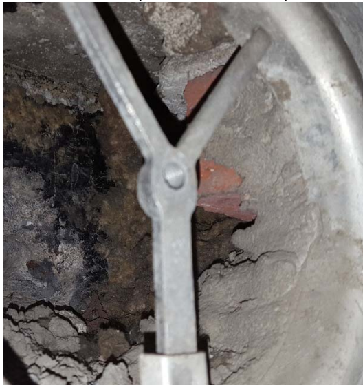
Kuvat 23 ja 24. Vanhojen korvausilma-aukkojen kautta on mv. seinien eristetilasta suora yhteys sisäilmaan.
