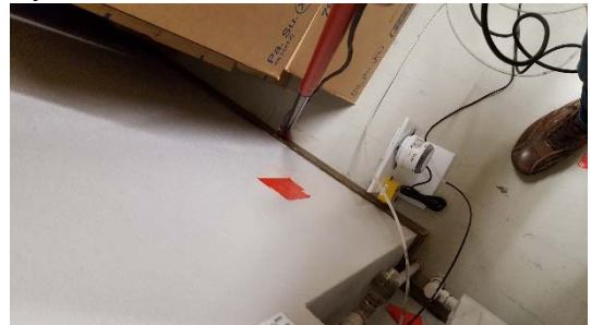
Kuva 44. Ilmavuotoa seinän ja lattian rajasta varastossa 145. Paine-eroa tutkittavan rakenteen yli seurattiin paine-eromittarilla.
