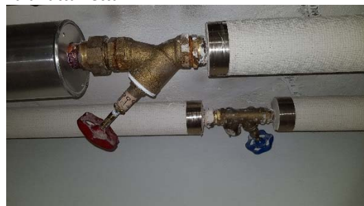
Kuva 10. Sulkujen putkiliitokset eivät ole tiiviit
