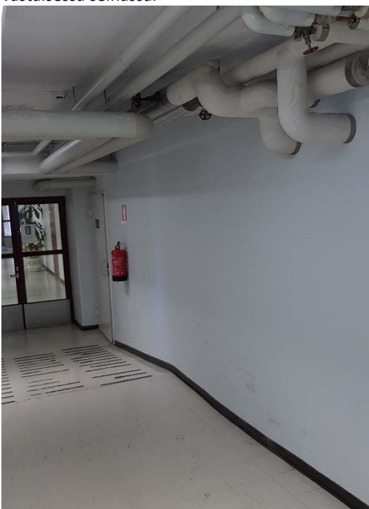
Kuva 8. Käytävän 076 lattiassa on pienellä alueella poikkeavaa kosteutta...
