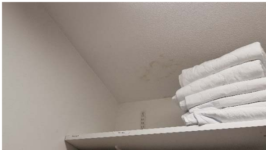
Kuva 39. Kosteusvauriojälki liinavaatevaraston kaasssa.
