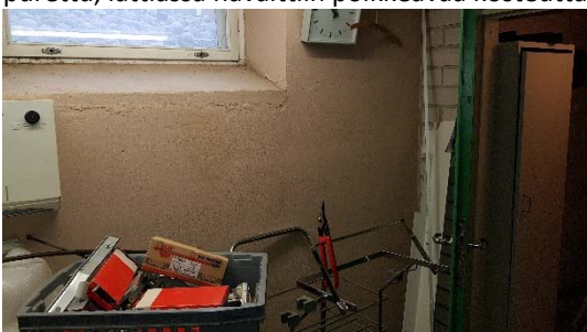
Kuva 6. Kosteusvauriojälkiä teknisen tilan maanvastaisessa seinässä.
