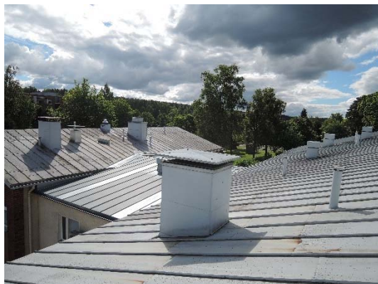
Kuva 31. Rakennusten vesikatteena on pelti.
