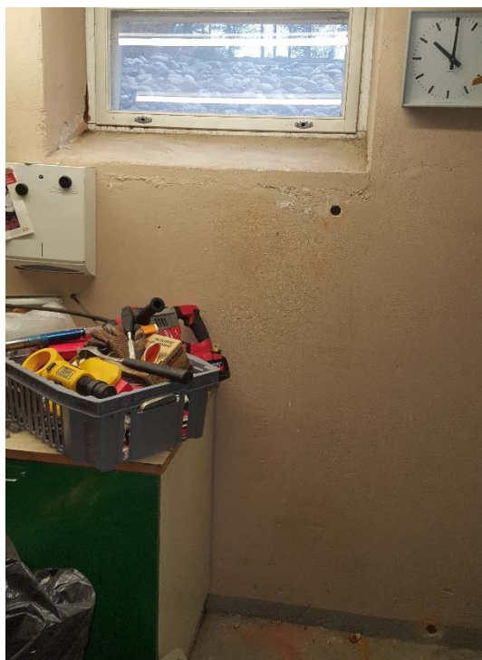
Kuva 19. Rakenneavaukset R8a ja R8b vanhan osan maanvastaiseen seinään.
