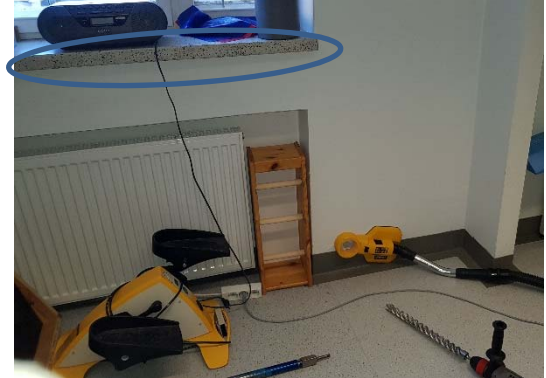
Kuva 26. Merkkiainetutkimuksissa todettiin kellarin ulkoseinien eristetilasta ilmavuotoa ikkunaliittymien kautta sisälle.
