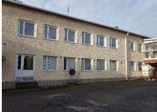
Kuva 25. Rakennuksen itäpuolen rapatut ulkoseinät ovat tiili-villa-tiili -rakenteisia ja sokkelin eristeenä on lastuvillalevyjä.
