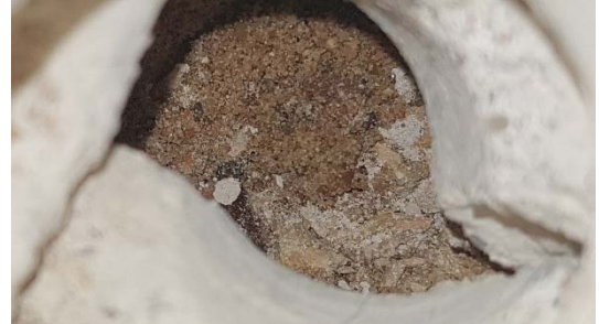
Kuva 12. Kotihoidon taukotilan lattian rakeneavauksen perusteella alapohjassa ei ole lämmöneristeitä.
