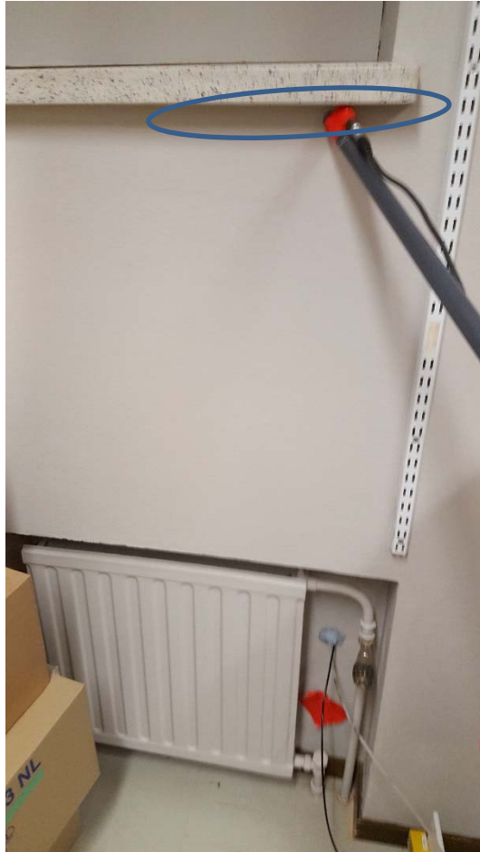
Kuva 41. Tutkittavaan rakenteeseen lasketaan merkkiainetta, jonka kulkeutumista sisäilmaan havainnoidaan vetyilmaisimella.
