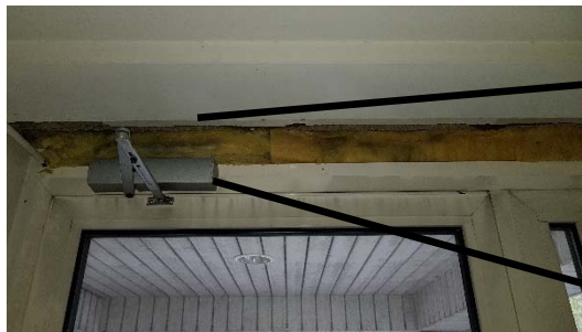
Kuvat 27 ja 28. Happivaraston 023 ulko-oven päältä on suora ilmayhteys seinän eristetilaan.
