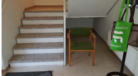
Kuva 11. Kosteuskartoituksessa havaittiin kosteuseroja mm. porrashuoneen 001 lattiassa.
