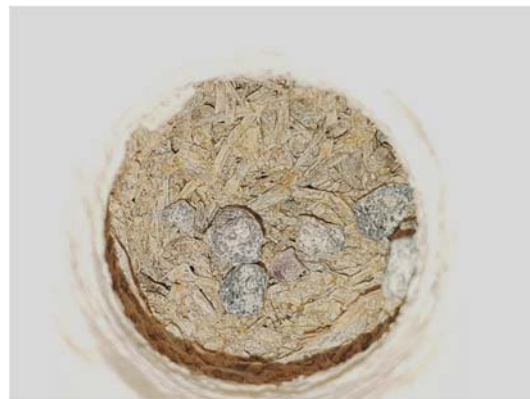
Kuva 16. Rakenneavauksin todettiin osassa ala-pohjaa käytetyn lämmöneristeenä lastuvillalevyä (Toja).
