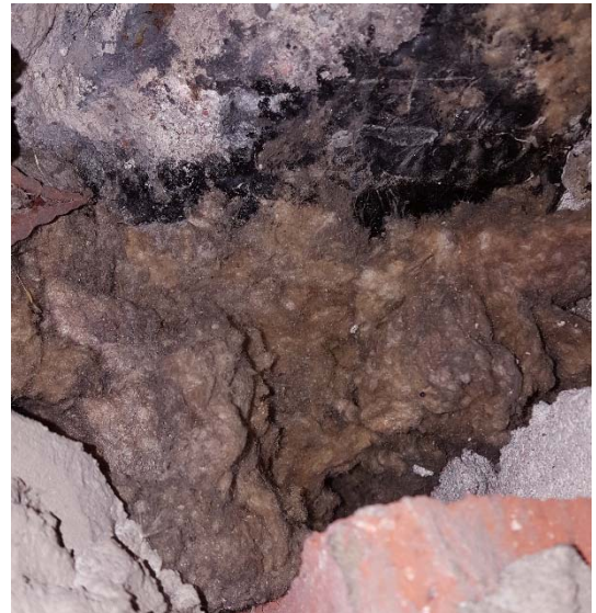
Kuvat 23 ja 24. Vanhojen korvausilma-aukkojen kautta on mv. seinien eristetilasta suora yhteys sisäilmaan.
