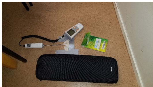
Kuva 13. Viiltomittauksin todettiin lattiapäällysteen alapuolisen liimatilan kosteudet korkeiksi alueilla, joissa pintakartoituksessa havaittiin kosteuseroja.
