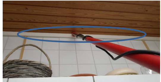
Kuva 43. Ilmavuotoa entisen ulkoseinän ja katon rajasta siivoustilassa 131.
