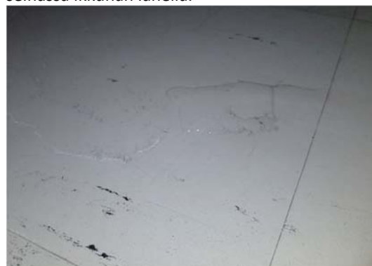
Kuva 9. ...ja yläpuolisesta putkiliitoksen vuodosta valunutta vettä.
