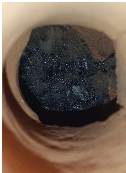
Kuva 20. Maanvastaisten seinien betoniulkokuoren sisäpinnoissa havaittiin useassa avauksessa bitumisively.
