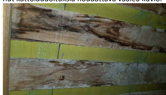
Kuva 36. Katon laudoitus on paikoin voimakkaasti tummunut kosteuden vaikutuksesta.
