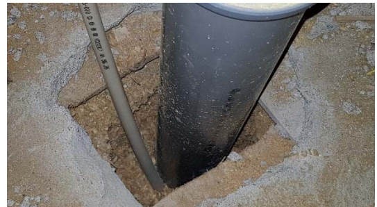
Kuva 40. Yläpohjarakenteen purutäyttö näkyvissä läpiviennin kohdalla.
