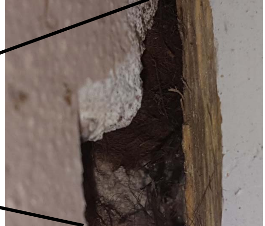
Kuvat 21 ja 22. Maanvastaisten seinien yläosien ikkuna-asennukset eivät ole tiiviit. Ikkunariveestä otetussa materiaalinäytteessä M28 esiintyi aktiivista mikrobikasvua.
