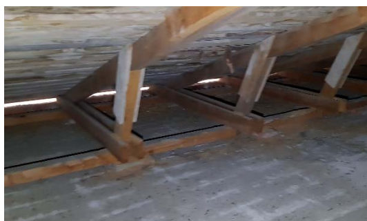
Kuva 33. Ullakkotila tuulettuu räystäältä.
