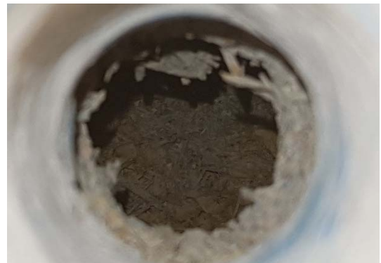
Kuva 30. Vanhan osan välipohjassa pintalaatan alla on lastuvillalevy, ilmatila ja purua.
