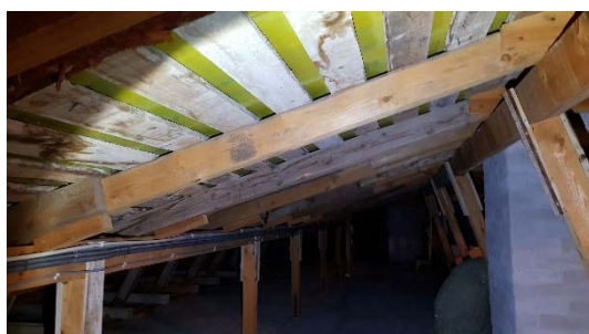
Kuva 35. Vihreäksi sisäpuolelta maalatun peltikaton alla oleva laudoitus.
