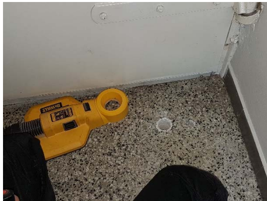
Kuvat 17 ja 18. Porrastasanteen 075 lastuvillaeristeisen laatan alla oli maapohjainen ilmatila, josta avauksen kautta kulkeutui sisälle lämmintä, pahanhajuista ilmaa.
