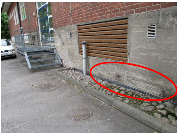
Kuva 23. Kadun puolella sokkelissa havaittavissa merkkejä voimakkaasta kosteusrasituksesta.
