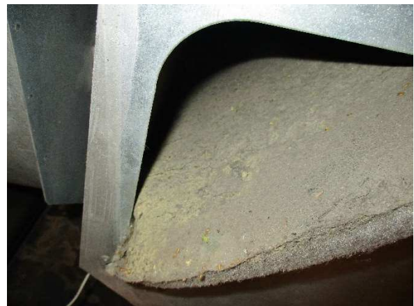
Kuva 14. Iv-koneen tuloilman karkeasuodatin on likainen ja tukossa.
