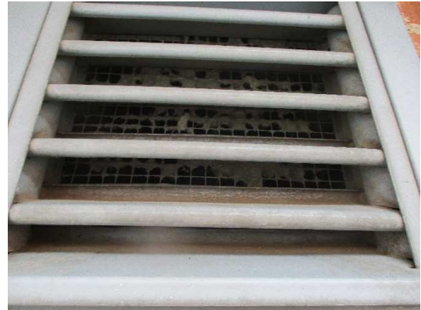
Kuva 8. Siipirakennuksen ilmanvaihtokoneen raitisilmasäleikkö. Säleikön verkossa on likaa.
