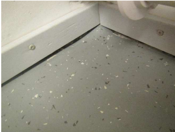
Kuva 25. Kellarikerroksen 008 Avoin ryhmä -huoneen lattiapäällysteen ja seinän välissä rako, jota oli yritetty tiivistää sanomalehtisuikaleilla.
