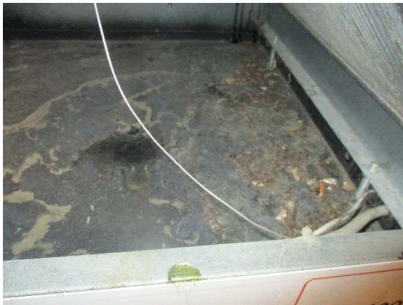
Kuva 15. Iv-koneen tuloilmakammiossa roskaa.
