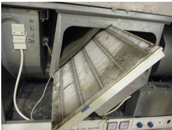
Kuva 13. Iv-koneen tuloilman paperisuodatin on kastunut, likainen ja kolhiintunut.
