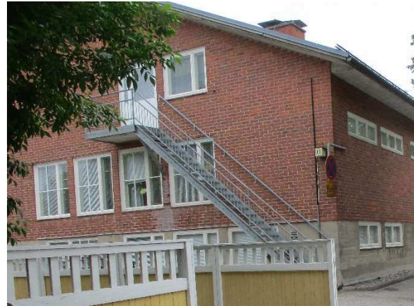
Kuva 26. Rakennuksen päädyssä, hätäoistumistien portaiden kohdalla ulkoseinässä ikkunoiden välissä on merkkejä tiilien rapautumisesta. Portaiden vinotuki ohjaa sadevedet seinälle.
