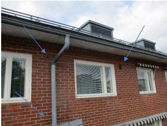
Kuva 19. Päärakennuksen ulkoseinässä on ikkunoiden välissä vanhat korvausilmäsäleiköt ja syöksytorven vieressä ruukkuputkiläpiviennit.
