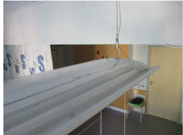
Kuva 20. Valaisinten päälle kertyy pölyä.
