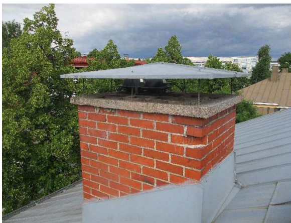
Kuva 9. Vanhan painovoimaisen ilmanvaihtopiipun päällä on kahden käytöstä poistetun takan takkaimurit.
