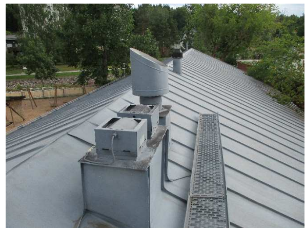
Kuva 10. Siipirakennuksen katolla on viemärin tuuletus, yläpohjan tuuletusputki, iv-koneen ulospuhallushajottaja, radonimuri ja märkäeteisen huippumuri.
