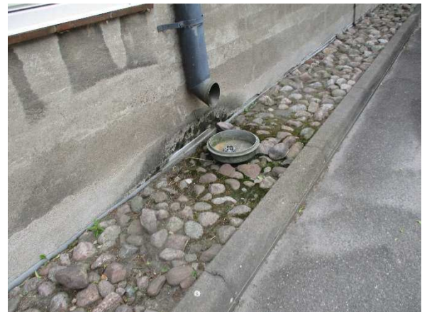
Kuva 22. Kadun puolella syöksytorvesta roiskunut vesi on kastellut perusmuuria.
