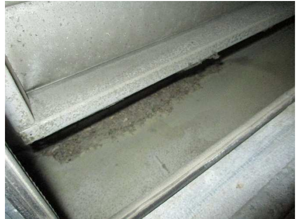
Kuva 2. TK 1 raitisilmakammion jälkeen, ennen suodatinta tuloilmakoneessa on hieman likaa.
