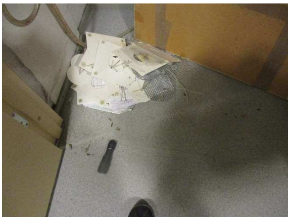
Kuva 17. Siipirakennuksen ilmanvaihtokoneen komeron lattialla on tuloilmahajottajien säätö- ja mittaosät.
