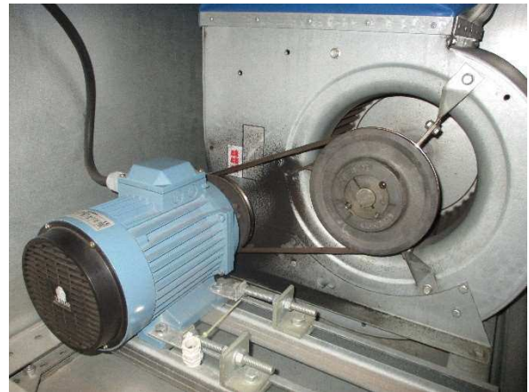
Kuva 4. PK 1 puhaltimen hihna löysällä ja kumin purua kammiossa.
