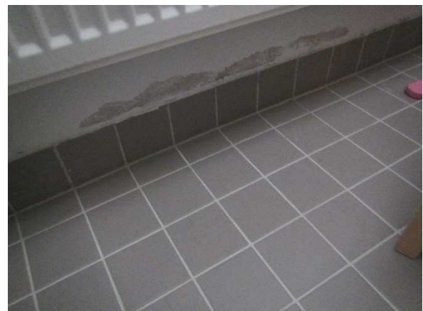
Kuva 24. Kellarin 018 huoneessa havaittiin kadun puolella perusmuurissa jälkiä kosteusrasituksesta.
