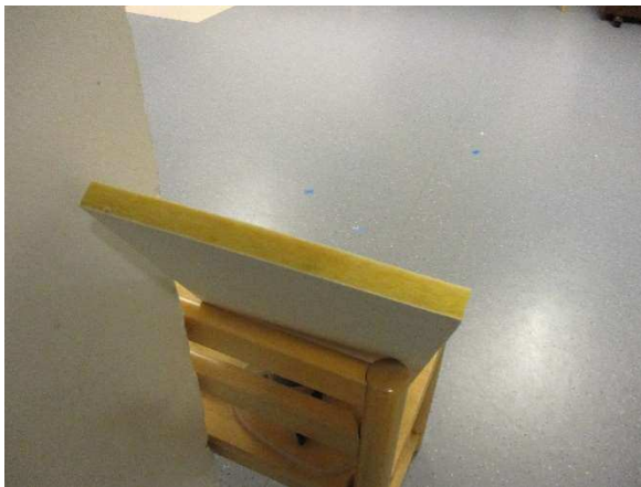
Kuva 21. Alaslasketun katon akustiikkalevyjen reunoja ei ole pinnoitettu, joten ne toimivat mineraalivillan kuitulähteenä.
