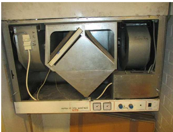
Kuva 11. Siipirakennuksen ilmanvaihtokone.
