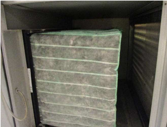
Kuva 1. TK 1 tuloilman suodattimet ovat siistit ja melko puhtaat.
