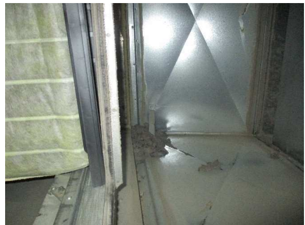
Kuva 6. PK 1 poistoilmakammiossa likaa ennen suodatinta.
