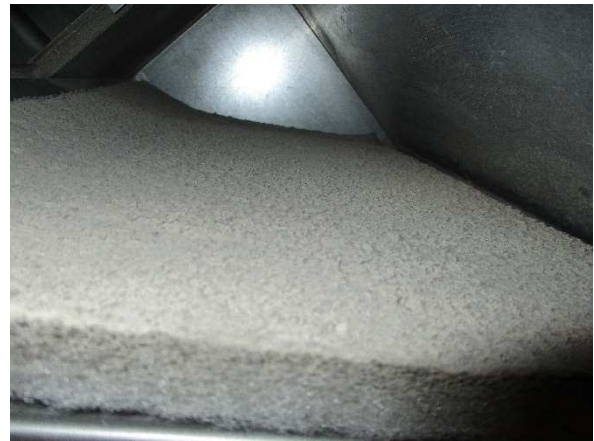
Kuva 16. Iv-koneen poistoilman suodatin on likainen ja tukossa.
