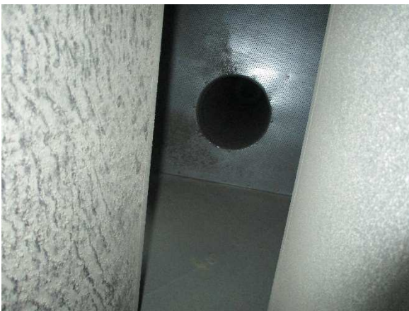
Kuva 5. PK 1 poistoilman äänenvaimentimet ja kanava melko likaiset.
