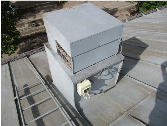
Kuva 7. Keittiön poistoilman huippumuri. Imurin ulospuhallusverkoissa on likaa.
