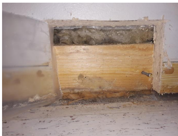
Kuva nro 3 US1 seinän rakenneavausta
