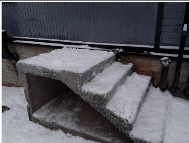
Kuva nro 4 ulkorappuset US1 rakenteen alueella
