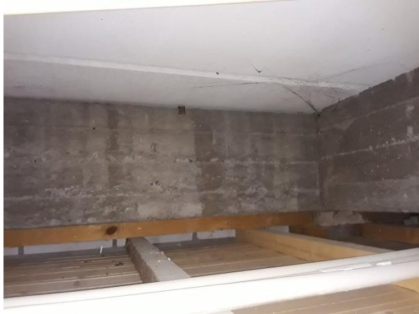
Kuva nro 8 yleiskuva alaslaskun yläpuolisesta tilasta
