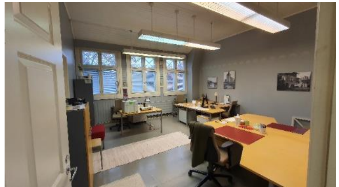
Kuva 10. Toisen kerroksen tilassa oli puulattia, kattopintana oli puupaneeli.
