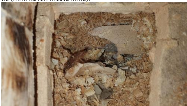
Kuva 28. Purutäytön joukossa havaittiin myös mm. lastuja, pahvia, tapettia, turvetta ja sanomalehtipaperia.
