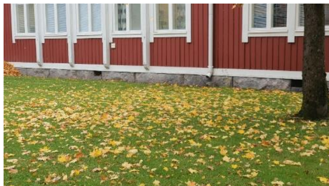
Kuva 4. Lounaan puolella nurmi ulottuu rakennuksen luonnonkivisokkeliin.
