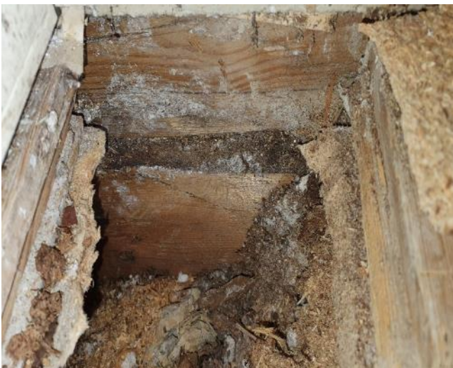
Kuva 40. Ulkoseinän alimpien hirsien kuntoa arvioitiin huoneen 106 ulkonurkkaan tehdyn rakenneavauksen kautta.
