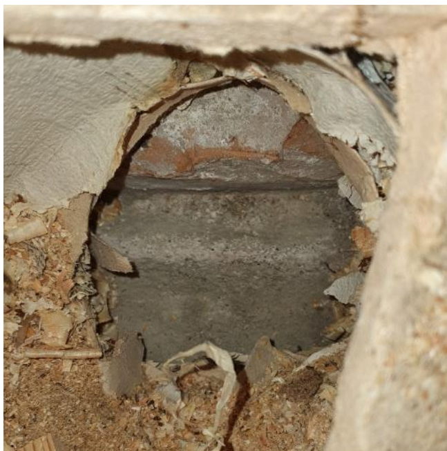
Kuva 47. Huoneiden 106 ja 107 välisen kantavan väliseinän tiilimuuraus lähtee alapohjan sisältä betoniperustuksen päältä.
