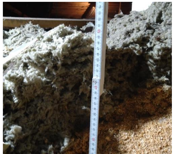
Kuva 54. Puhallusvillan alle on jätetty alkuperäiset puru- ja turve-eristeet.
