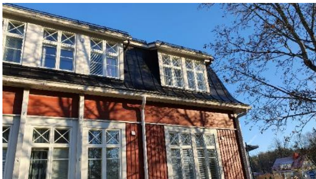
Kuva 42. Hirsiseinä ulottuu 2. kerroksen ikkunoiden alareunan tasolle, ikkunaväleissä ylemmäs.
