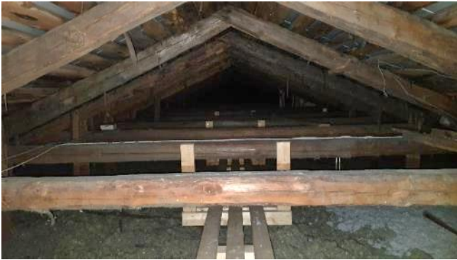
Kuva 13. Vesikaton puurakenteet olivat aistinvaraisesti arvioituna hyväkuntoiset.
