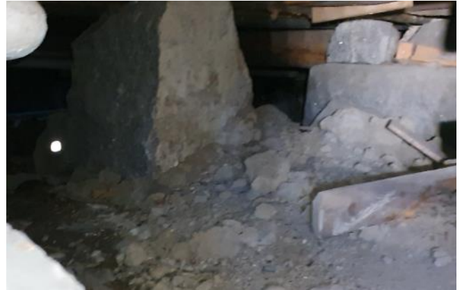
Kuva 22. Alapohjan runko on tuettu luonnonkivin. Ryömintätilan pohjalle on jätetty jonkin verran orgaanista materiaalia, mm. puutavaraa.
