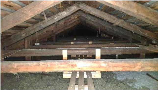
Kuva 56. Vesikaton puurakenteet olivat hyväkuntoiset.
