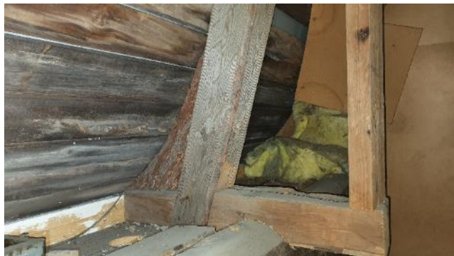
Kuva 46. Hirsiseinän yläpuolinen rakenne kotelioimattomana ullakkotilana olevassa varastossa 201.
