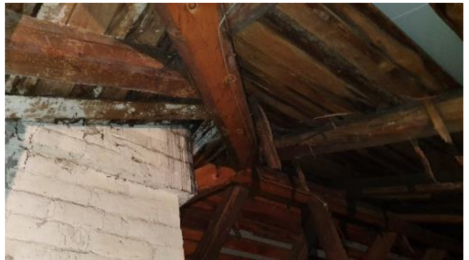
Kuva 16. Vuotojälkiä savupiipussa.
