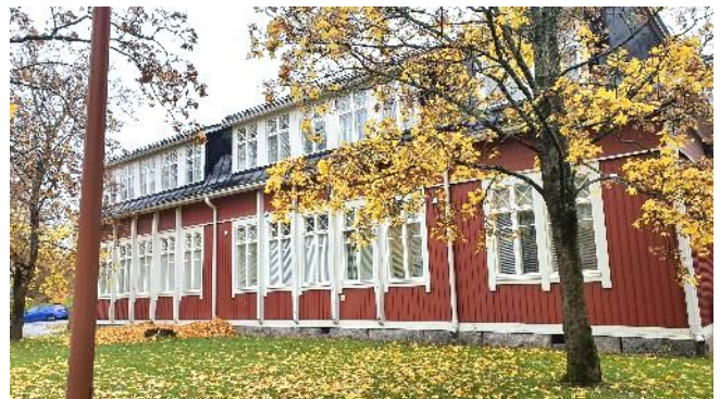
Kuva 2. Rakennuksen lounaan puoleinen julkisivu.
