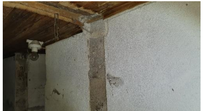
Kuva 18. Kellaritilan yläpuolinen välipohja on puurakenteinen.
