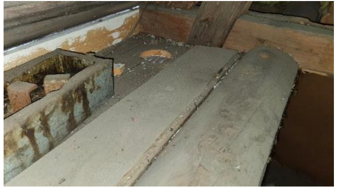
Kuva 14. Yläpohjatila tuulettuu räystäällä olevien venttiilien kautta.
