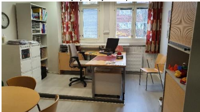
Kuva 45. Ikkunoiden vieressä toisen kerroksen ulkoseinä on tuotu sisälle kevytrakenteisena mansardikaton muotoiluun vuoksi.
