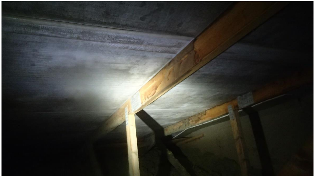
Kuva 12 Luppakorvien tilojen kohdalla yläpohjassa on runsaasti kosteusjälkiä. Kosteusjälkiä on myös Karvatassujen tilojen yläpuolella takapihan puoleisella räystääslinjalla.
