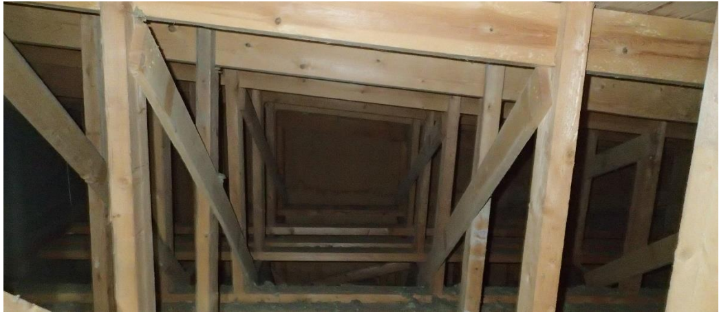
Kuva 8 IV-konehuoneen ja salin yläpohjatilassa ei havaittu juurikaan vesijälkiä
