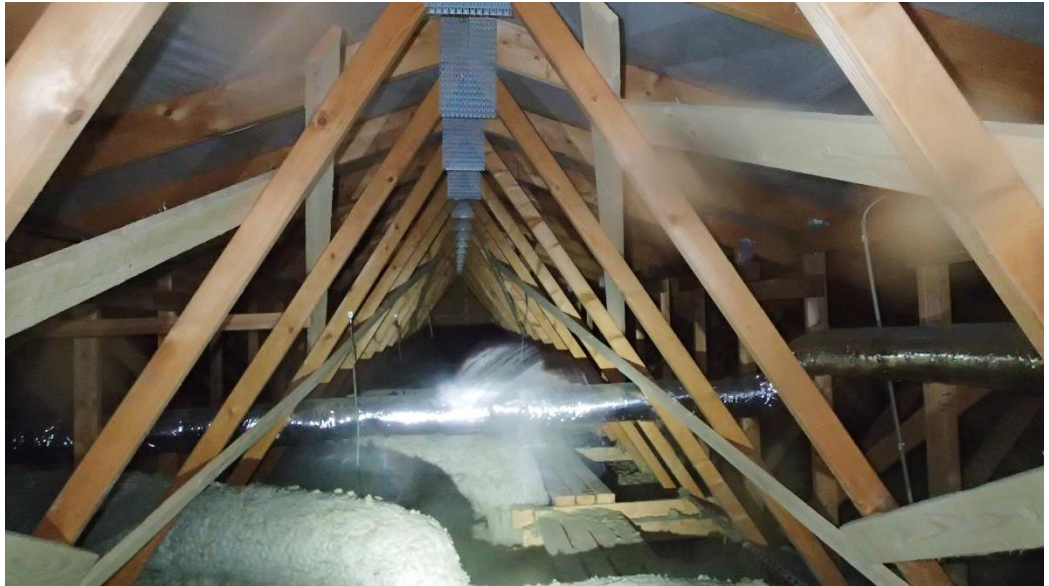
Kuva 11 Yleiskuvaa yläpohjatilasta Nöponenien kohdalla. Tarkastusluukun lähellä olevaa jii-riä lukuun ottamatta ei havaittu vesivuotojälkiä
