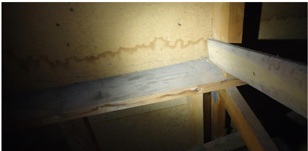
Kuva 10 Vesijälki sijaitsee tuulensuojalevytyksessä eikä kosteutta ole päässyt sisätilojen vastaisiin rakenteisiin. Yläpohjan tuuletus on hyvä, joten kosteus on päässyt kuivumaan nopeasti.
