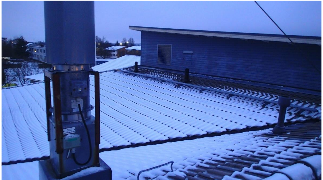
Kuva 3 Vesikatetta ja jiiirin kohtaa
