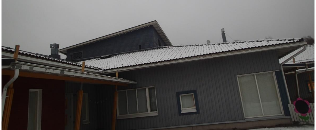
Kuva 2 Yleiskuvaa vesikatteesta. Vesikatteessa on useita jiiirikohtia, joiden toteutustapa on epätiivis.
