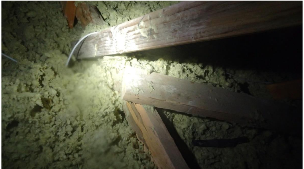
Kuva 13 Vettä on päässyt eristetilaan ja höyrynsulkumuovin päälle. Höyrynsulkumuovin epätiiveykskohdista vettä on valunut sisätiloihin saakka.
