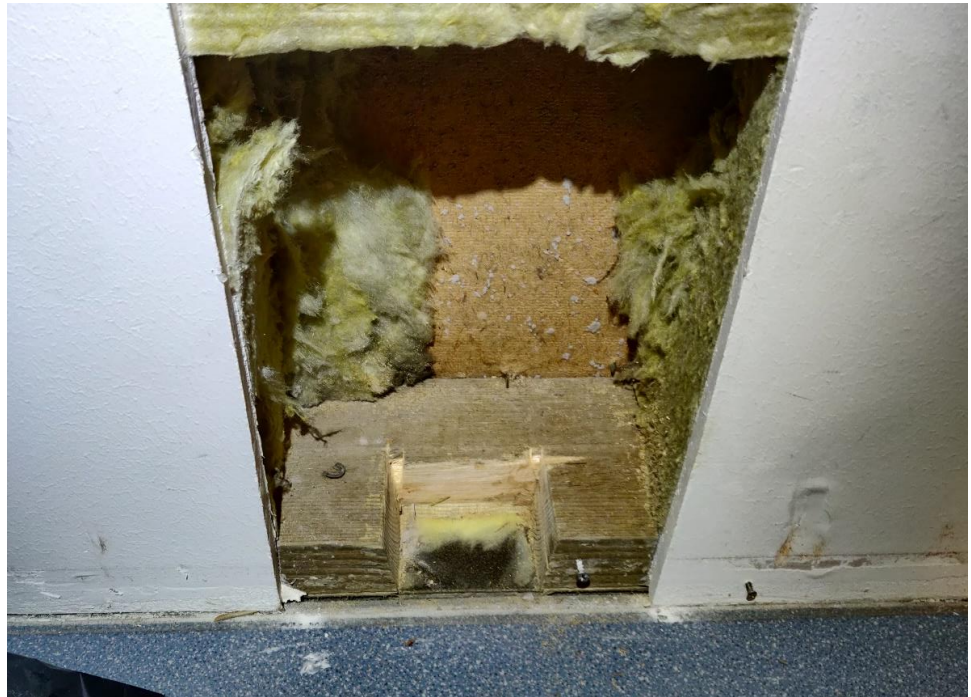
Kuva 1 Ulkoseinärakennetta tutkimuspisteessä TP1.
