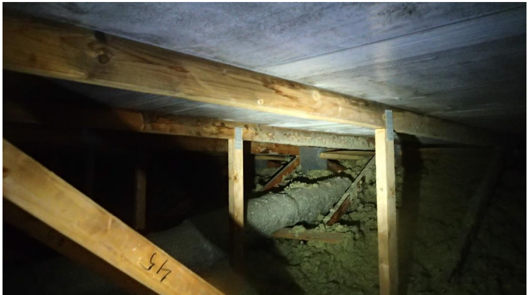
Kuva 14 Suurin osa vedestä ohjautuu aluskatetta pitkin ulos, mutta kosteutta on päässyt runsaasti yläpohjatilaan.
