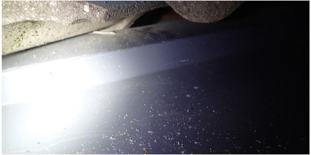
Kuva 5 Jiiripellin ja tiilakatteen välissä on rakoja, joista vesi ja lumi pääsee kulkeutumaan aluskatteelle ja yläpohjatilaa.
