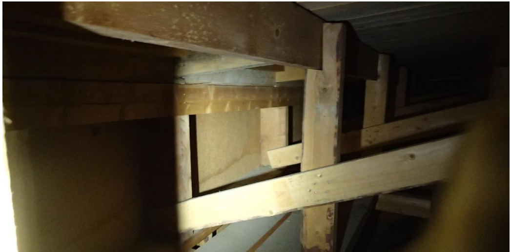
Kuva 9 IV-konehuoneen ja salin yläpohjatilan ainoat vesijäljet sijaitsevat räystäslinjalla. Todennäköisesti räystäään alta on päässyt yläpohjatilaan tuiskulunta.
