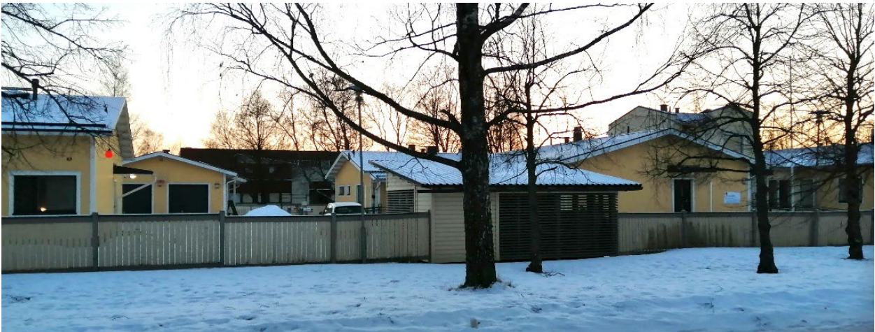
Kuva A-klinikan rakennuksista Kalkkitieltä kuvattuna, kevättalvi 2024.
