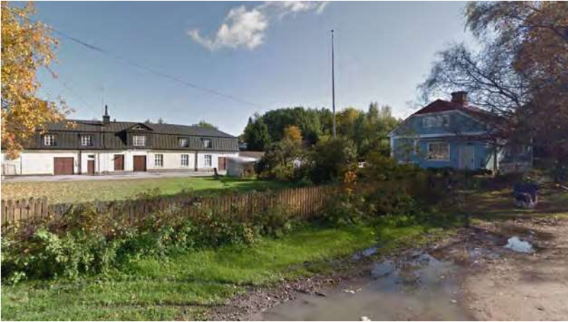
Kuva Kallenkadulta katsottuna. Kuvassa näkyy vasemmalla kiinteistöllä 1 sijaitseva rakennus. Rakennuksessa on alakerrassa liiketilaa sekä varastotilaa ja yläkerrassa asumista. Oikealla tontilla 2 nykyään omakotitalona toimiva sininen 109k-m 2 rakennus vuodelta 1928. Kuvalähde: 2024 Google
