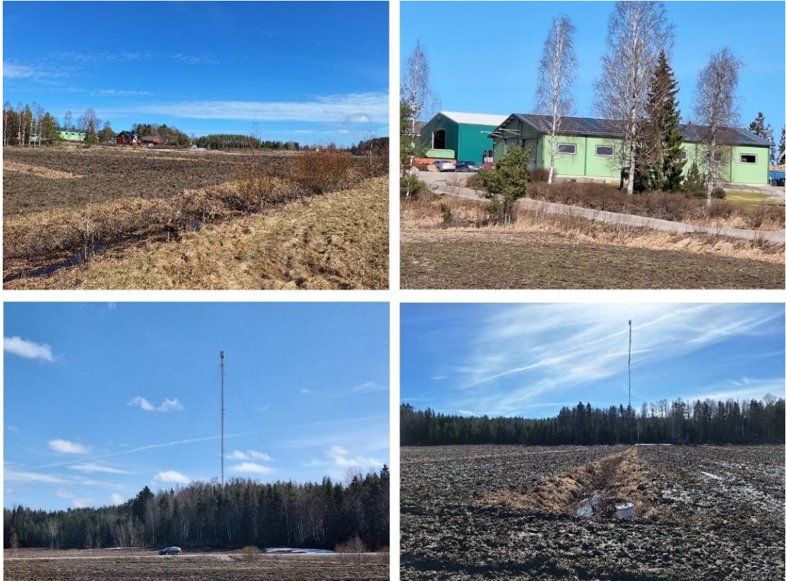
Kuva 29: Hankealueen läheisyydessä sijaitsevat tekniset rakenteet
