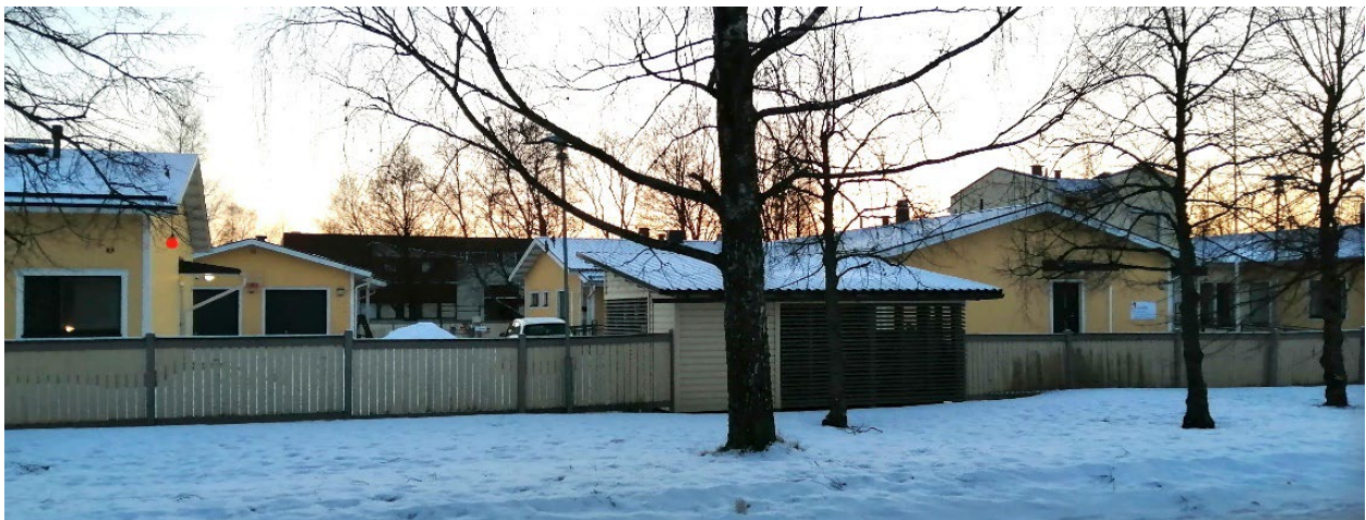
Kuva A-klinikan rakennuksista Kalkkitieltä kuvattuna, kevättalvi 2024.
