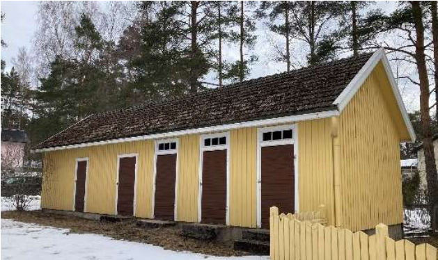
Kuvat yllänä: Ampujantie 1 toukokuussa 2023. Purettu päiväkotirakennuksen suunnitelmat olivat vuodelta 1947, joiden mukaan rakennus oli alun perin tehty turvepehkutehtaan taloudenhoitajan asuinrakennukseksi. Kuva vas.: Talousrakennus oli myös rakennettu todennäköisesti 1940-1950-luvun vaiheilla.
