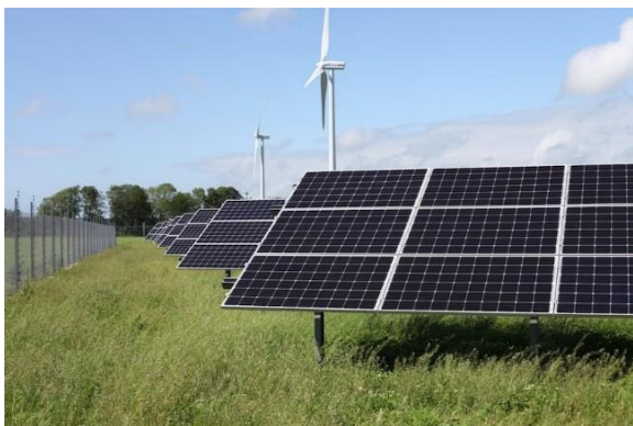
Kuva 3. Esimerkki aurinkopaneeleista alumiinikehyksellä maakiinnikkeissä (vasemmalla). Kuvassa näkyy Varbergs Energin Solsidan-puisto Tvååkerissa Ruotsissa. Esimerkki aurinkopaneeleista yksiakselisilla aurinkokeräimillä (oikealla).
