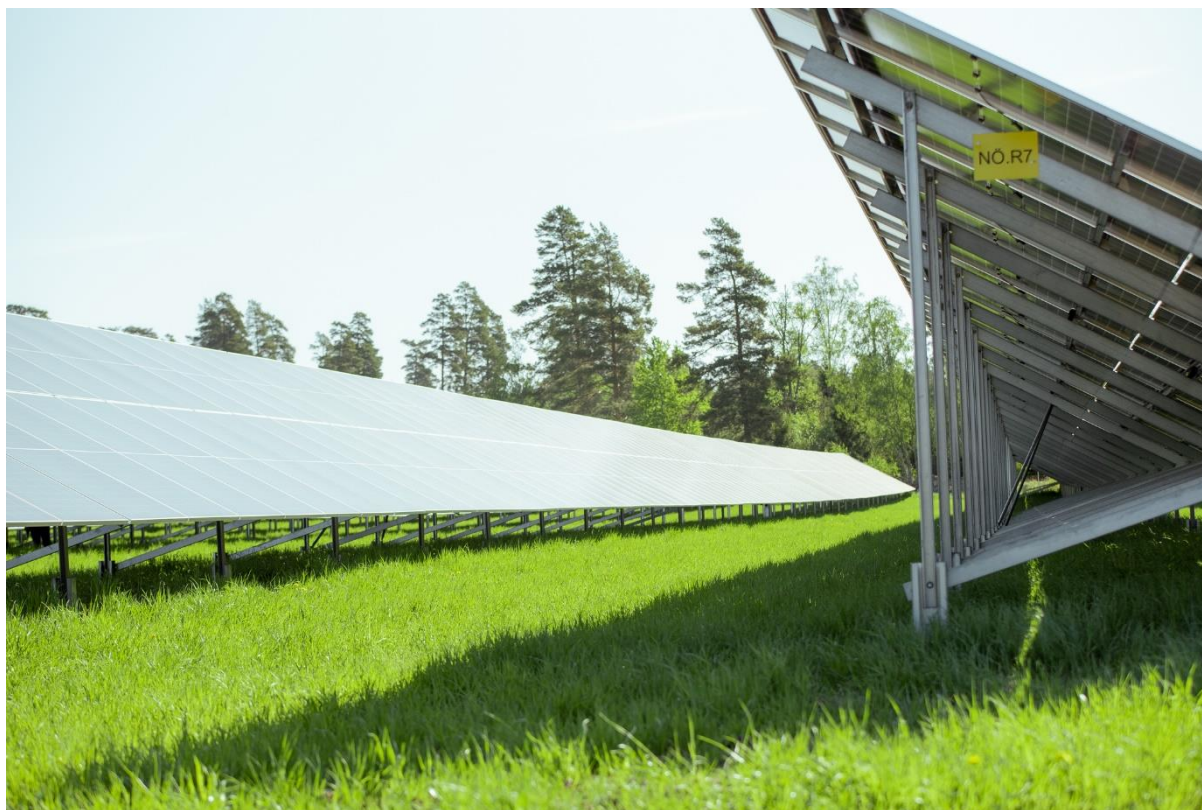
Kuva 4. Aurinkopaneelit asennetaan pitkiin riveihin, noin 5–6 metrin välein. Ruoho sekä muu kasvillisuus voivat kasvaa paneelien alla, minkä vuoksi maa ei kovetu ja huleveden voivat imeytyä hyvin siihen.
