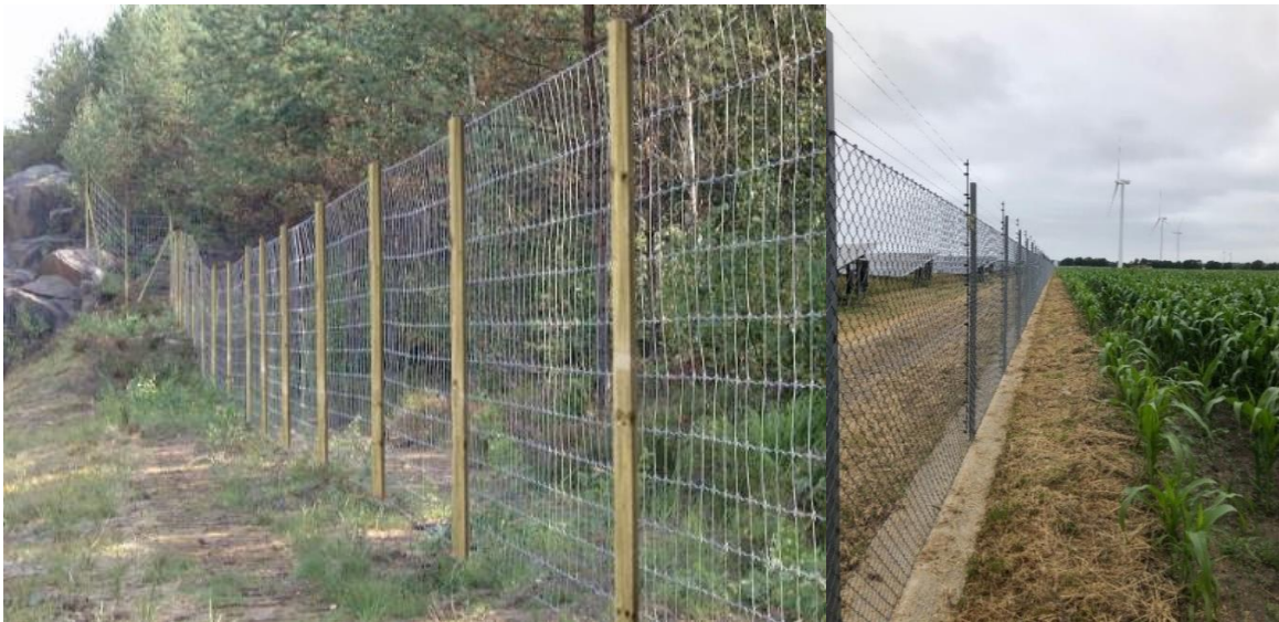
Kuva 2. Esimerkki riista-aidasta puutolpilla (kuva vasemmalla) ja teollisuusaidan toteutus sisäpuolisella ylikiipeämissuojalla (kuva oikealla).
