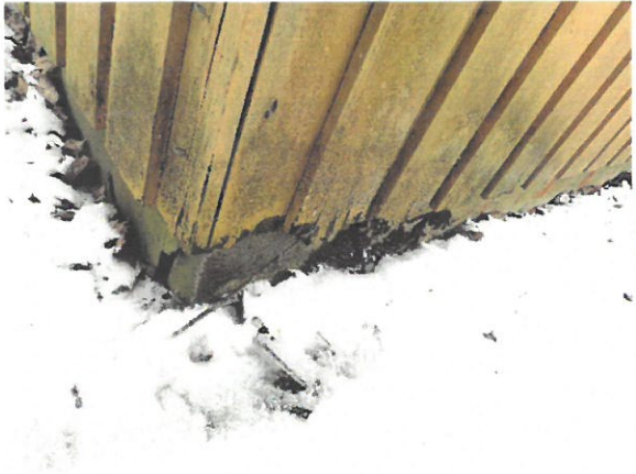
nurkassa sokkeli halki ja laudoituksen alareunassa sokkelissa halkeamia vaurioita
