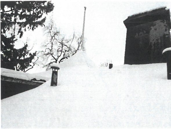
kuva seinätikkaiden yläpäästä
