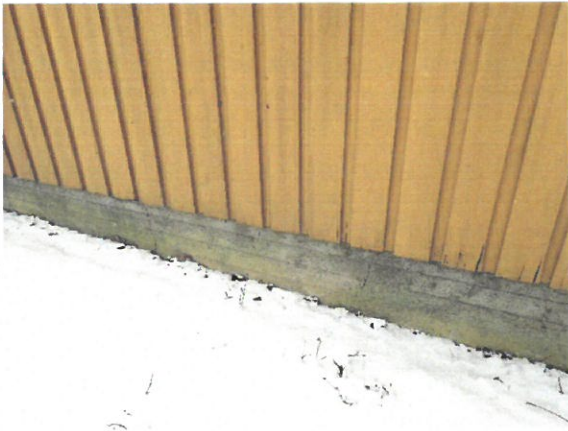
nurkassa sokkeli halki ja laudoituksen alareunassa sokkelissa halkeamia vaurioita
