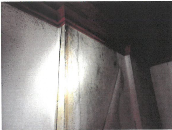
piipun ympärillä sisäpinnoilla mikrobikasvustoa
