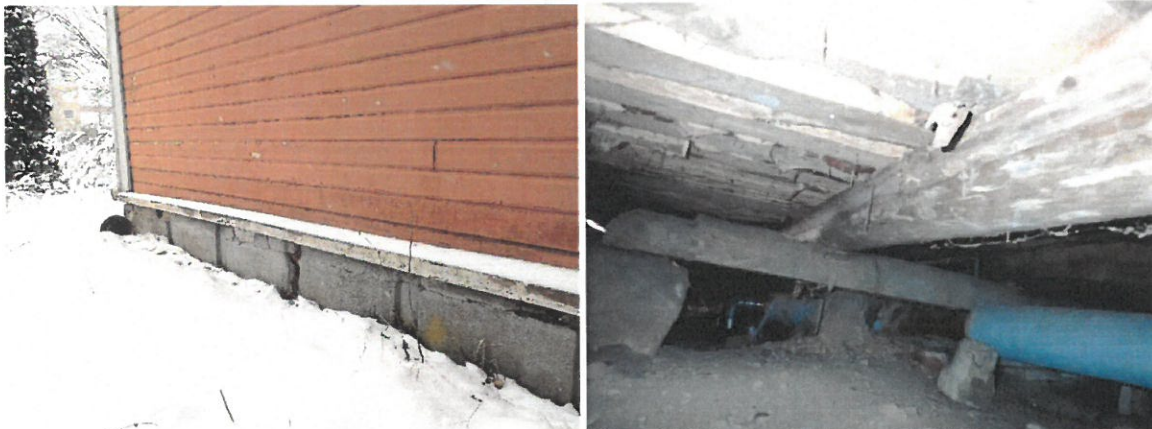
korjausmuuraus / valu sokkelin yläreunassa
