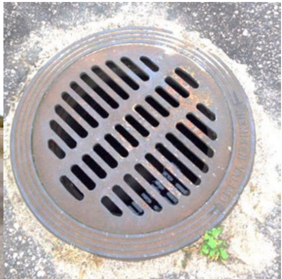
Kuva 5 Tankkauspuoleisen öljynerotuskaivo
