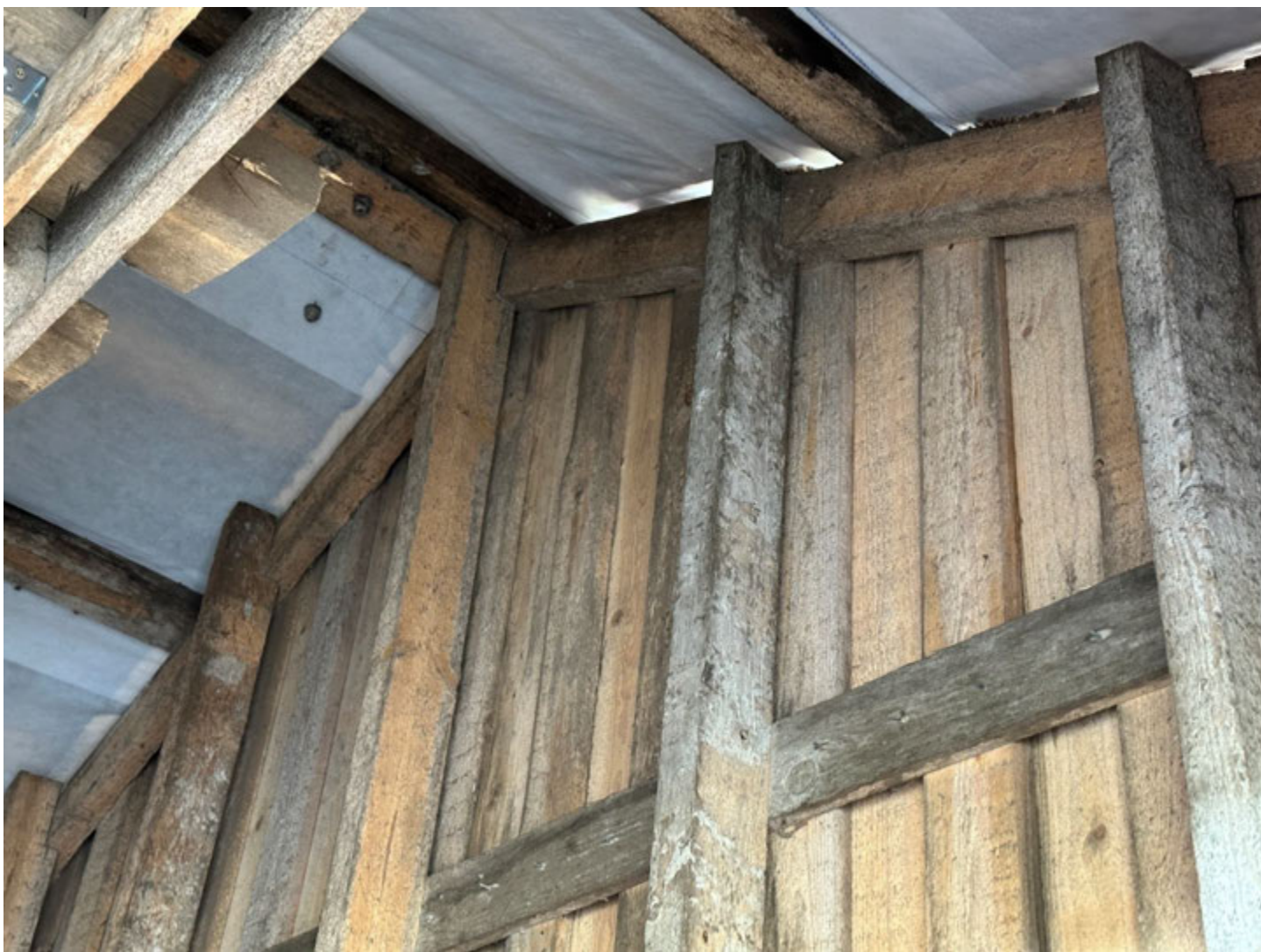
Kuva 7: Tuulettuva kattorakenne ilman yläpohjaa.
