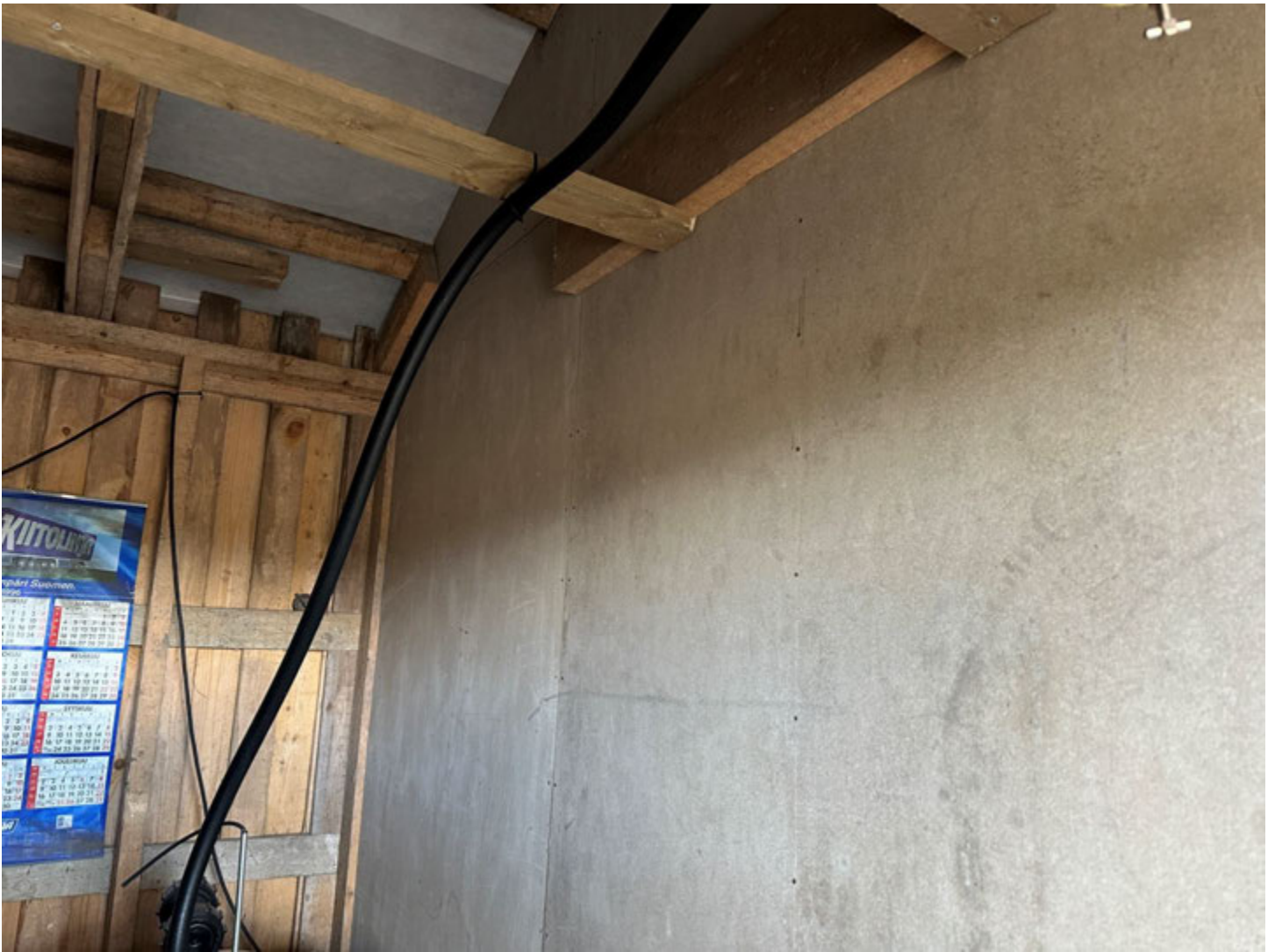
Kuva6: Palo-osastointi. 100LL ja 98 autobensiini eri osastoissa
