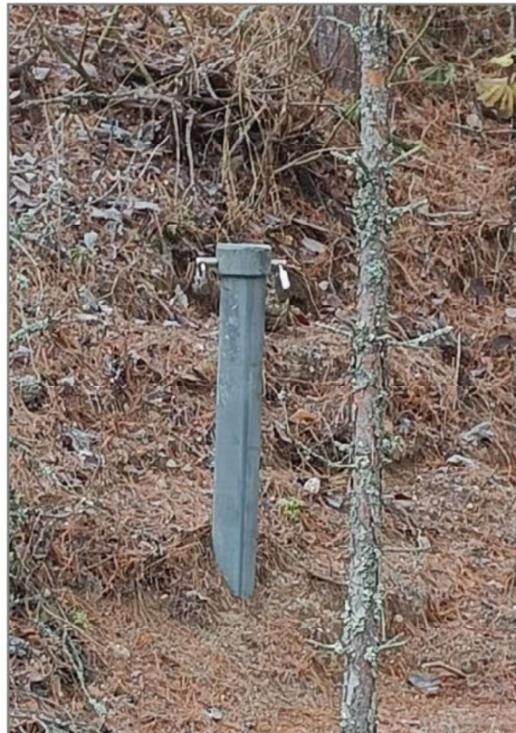
Kuva 13. Soranottoalueella oleva pohjavesiputki Hp1.
