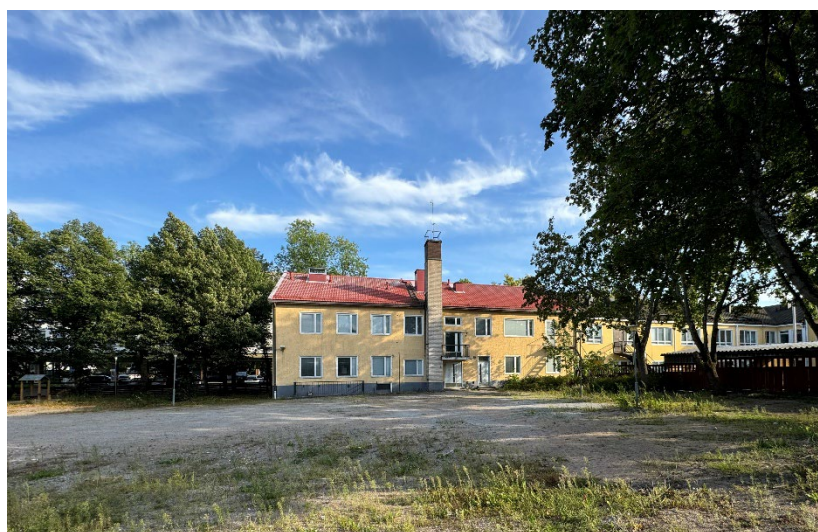
Kuva lisärakentamiselle kaavoitettavan tontin reunalta.
