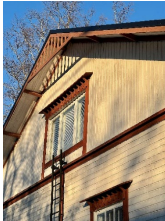
Vähäsillan kadun puoleinen yläikkuna poikkeaa muista ikkunoista.
