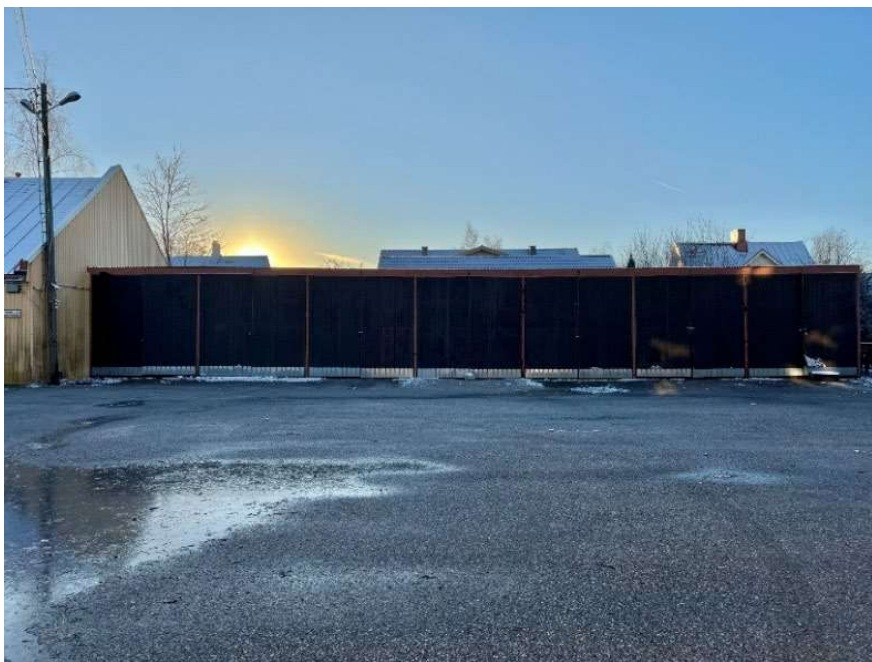
3 Matala autotallirakennus sijaitsee talo 10:n takana. Piha on päällystetty vettäläpäisemättömällä materiaalilla lähes kauttaaltaan.
