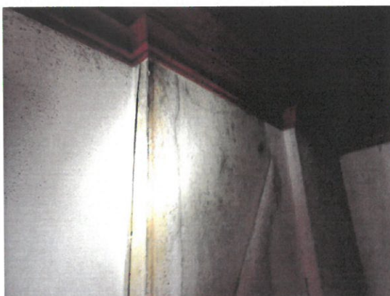
piipun ympärillä sisäpinnoilla mikrobikasvustoa
