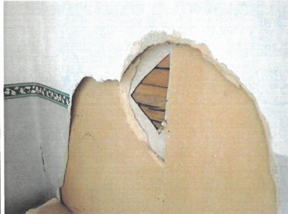
tarkastettu runkorakenne; hirsi
