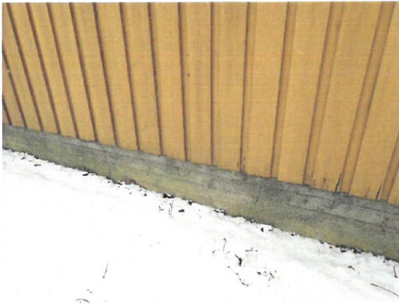
nurkassa sokkeli halki ja laudoituksen alareunassa sokkelissa halkeamia vaurioita
