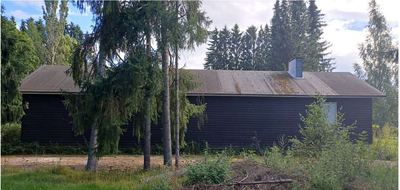
Kuvat 22-25. Puutarha-alueen viimeinen rakennus: varastona toimiva talousrakennus. Kuvat: Juha Mäki
