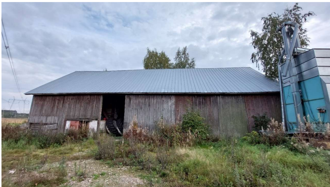
Kuva 9. Rakennus D ulkoa kuvattuna.
