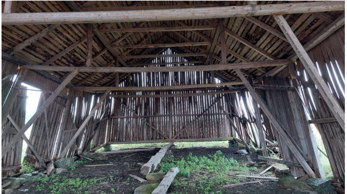
Kuva 7. Rakennus B sisältä kuvattuna.
