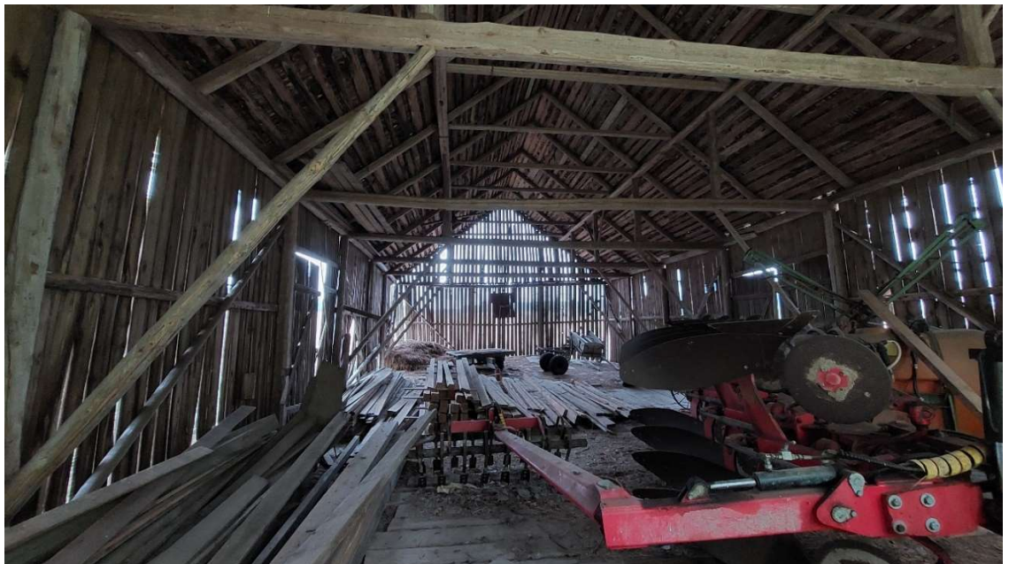
Kuva 8. Rakennus C sisältä kuvattuna.
