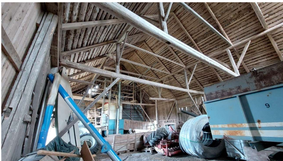
Kuva 10. Rakennus D sisältä kuvattuna.
