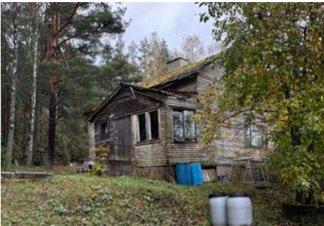
Rakennus on purkukuntoinen.
