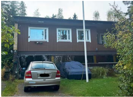
Rakennuksen kellarikerros on osittain kylmää tilaa.
