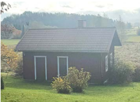
Saunarakennuksen ulkoväritys on ollut keltavalkoinen vuonna 1993.
