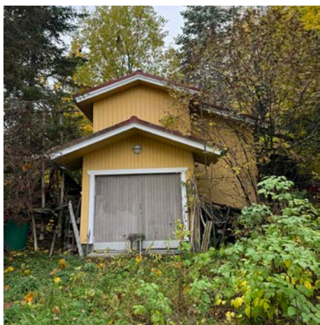
B-rakennuksessa on ollut sauna, autotalli ja varasto. Autotallin katto muutettu tasakatosta harjakatoksi.
