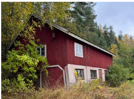
C-rakennus on alunperin rakennettu navetaksi.
