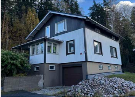
A-rakennus näyttää puutalolta, mutta sen pääasiallinen julkisivumateriaali on pelti.
