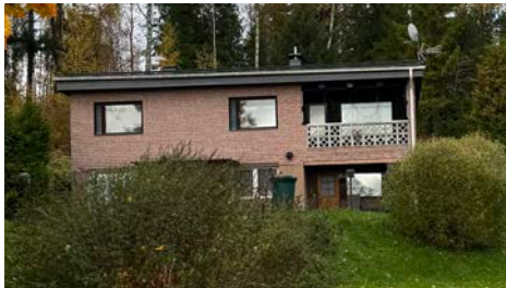
A- rakennuksen 1. kerroksessa oli alunperin autotalli, joka on myöhemmin muutettu makuuhuoneeksi ja autotallin oven tilalle on muurattu ikkuna.
