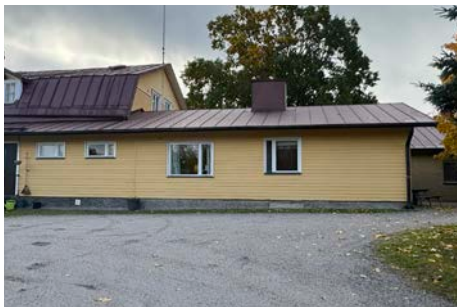
A-rakennuksen ensimmäiseen laajennukseen sijoitettiin muun muassa askarteluhuone ja varastotilaa.
