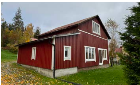
Ilmakuvien perusteella B-rakennuksen julkisivut on uusittu vuonna 2023. Perustuksista voidaan päätellä, että matalampi rakennusosa on rakennettu myöhemmin.
