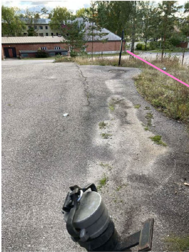
Kuva 10. Sulkuventtiili ja sadevesikaivo
