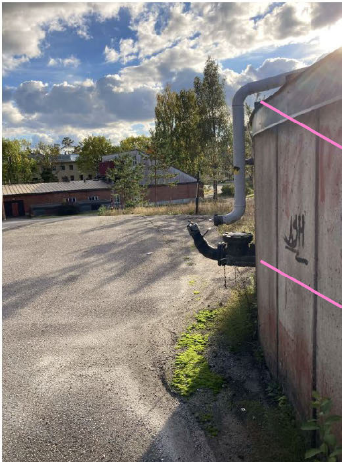
Kuva 11. Vallitilan seinusta; vaahdonsyöttö ja täyttöyhde.
