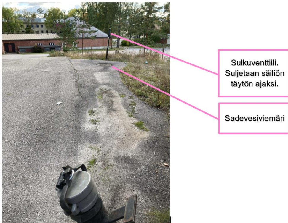
Kuva 9-2. Sulkuventtiilin ja sadevesikaivon sijainti.
