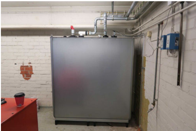
Varavoimakonehuoneen uusi öljysäiliö
