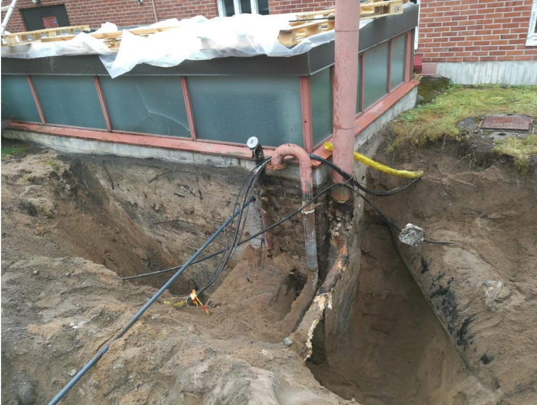
Kuva 1: Täyttöputken edustan kaivualuetta.
