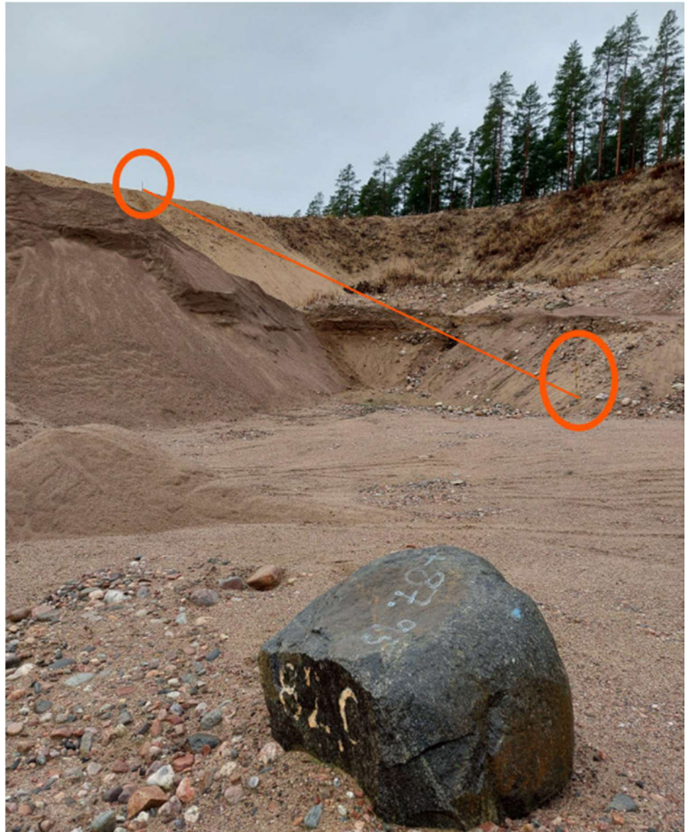
Kuva 4 Kiveen merkitty korko +82 on maanpinnan taso. Luiskan juuri (punaisella merkitty linja) on merkitty maastoon tikuilla (ympyröity), jotta jatkossa ei mennä liian lähelle kaivuualueen reunaa.
