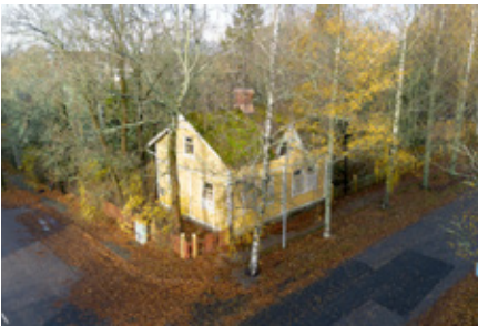
Moision Rantapuiston kohteisiin lukeutuu myös kunnostettava puutalo.
